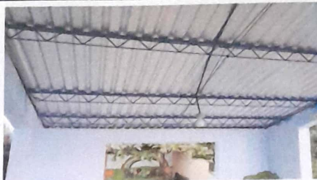
No.2 Mantenimiento a estructura existente limpieza+lijado y pintado
