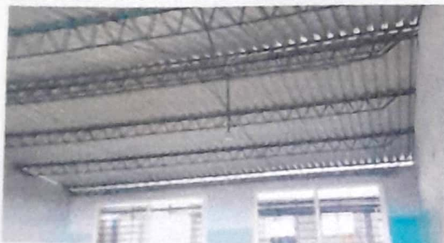
No.1 Sustitución de cubierta metálica con lámina troquelada calibre 26
