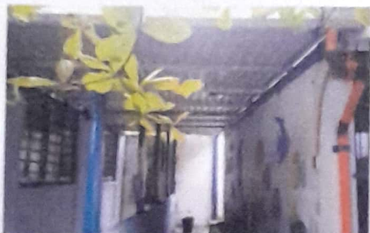
No.3 Sustitución de estructura metálica + cubierta existente mano de obra
