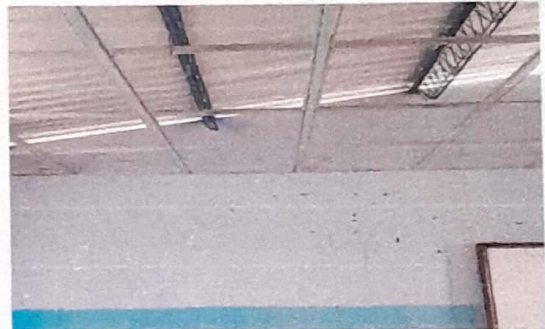
No.4 Sustitución de cielo a cielo falso acabado blanco en 2 aulas
