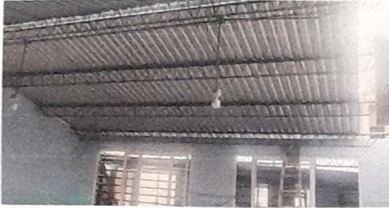
No. 1 Sustitución de cubierta metálica con lámina troquelada calibre 26
