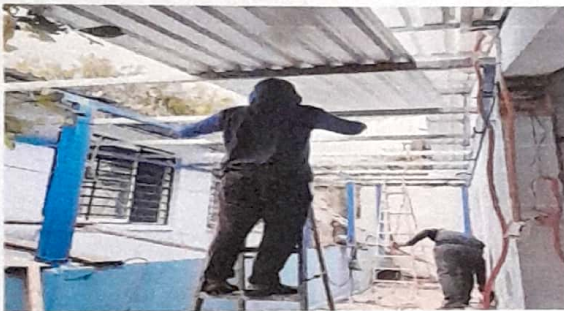
No.3 Sustitución de estructura metálica + cubierta existente mano de obra
