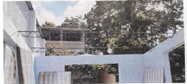
No.2 Mantenimiento a estructura existente Ilmpeza+lijado y pintado
