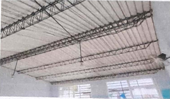
No. 1 Sustitución de cubierta metálica con lámina troquelada calibre 26
