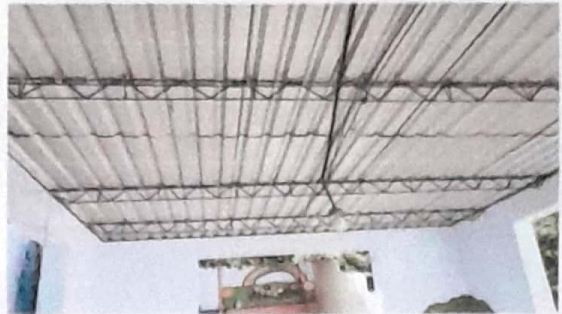
No. 2 Mantenimiento a estructura existente limpieza+lijado y pintado
