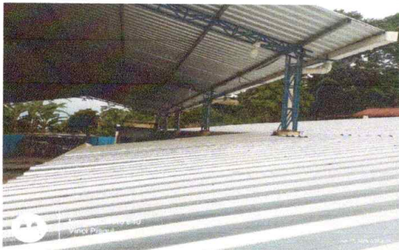
Foto 3: Sustrucción de techo de entechado de la escuela
