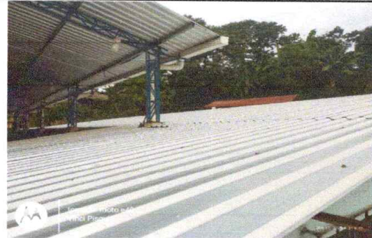
Foto 4: Sustrucción de techo de entechado de la escuela
