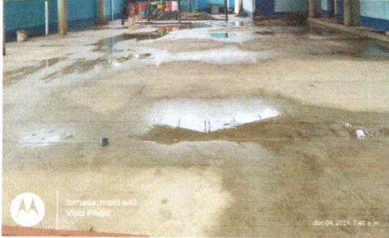
Foto 1: Sustrucción de piso de cancha de básquetbol
