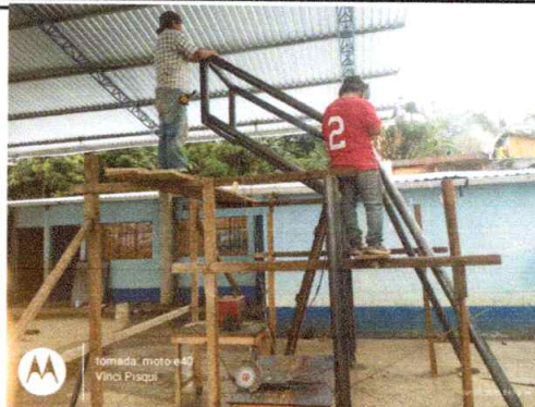
Foto 2: Sustitución de módulo de la canastas de básquetbol
