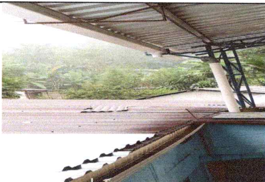
Foto 3: Sustitución de techo de en techado de la escuela
