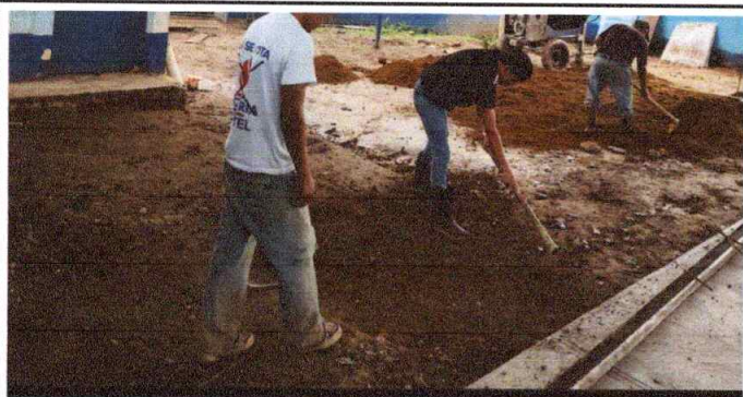
Foto1: Sustitución de piso de cancha de básquetbol
