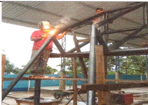
Foto 5: Sustitución de módulo de la canastas de básquetbol
