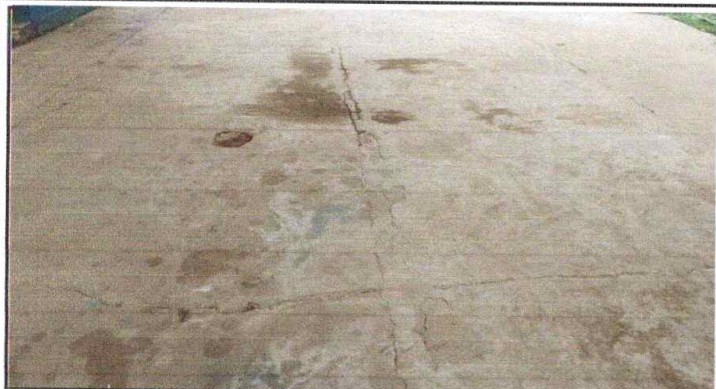
Sustitución de piso de cancha de básquetbol
