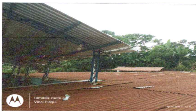
Sustitución de techo de entechado de la escuela
