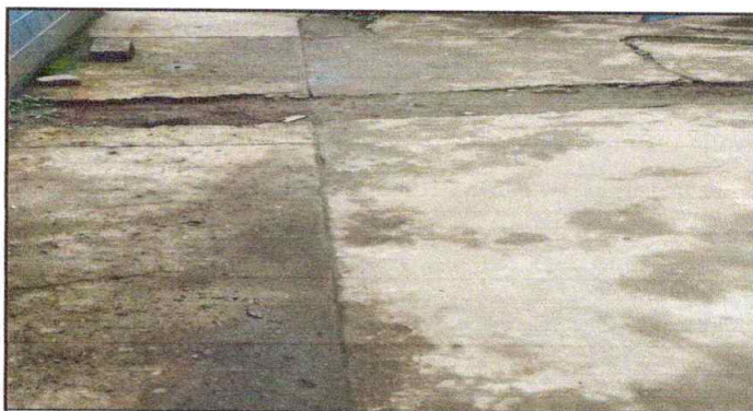
Sustitución de piso de cancha de basquetbol
