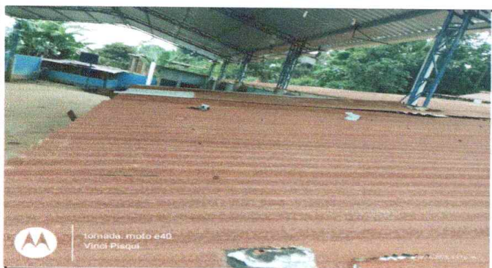
Sustitución de techo de entechado de la escuela
