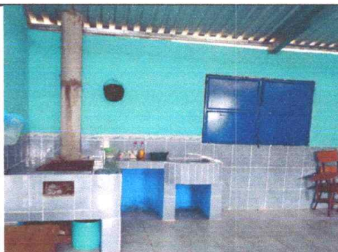
Foto No. 10 Sustitución de estufa y mesa en cocina con azulejo
