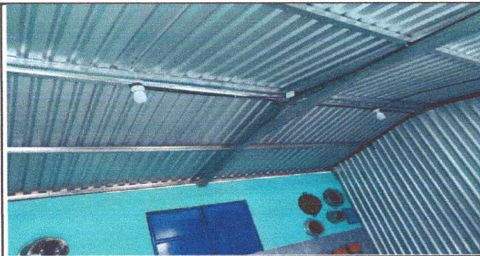
Foto No.1 Sustitución de cubierta metálica
