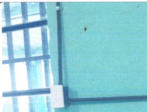
Foto No. 9 sustitución de tomacorrientes
