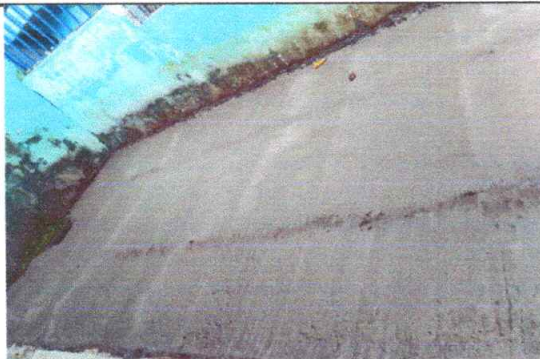
Foto No.3 Sustitución de torta de concreto
