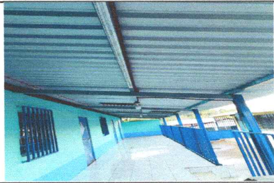
Foto No.2 Sustitución de estructura portante con estructura metálica galvanizada.
