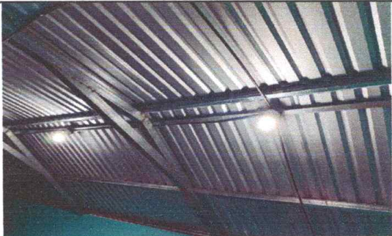
Foto No.6 Sustitución de luminarias de 30 whatts
