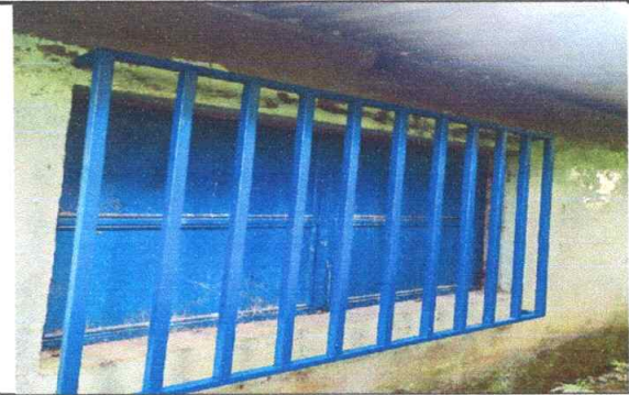
Foto No.4 Sustitución de balcones en ventanas de metal
