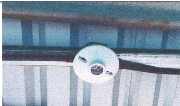
Foto No.8 Sustitución de plafoneras
