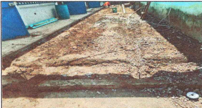
Foto No. 3 sustrucción de torta de concreto
