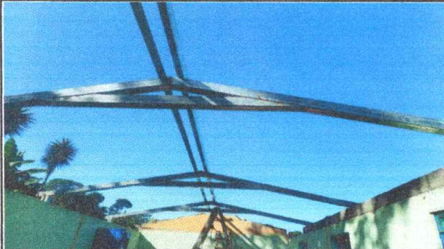
Foto No. 1 Sustrucción de cubierta metálica
