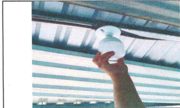
Foto 6: Sustrucción de luminarias de 30 watts
