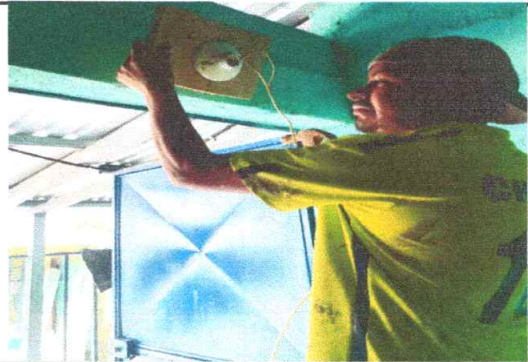
Foto No.8 Sustitución de plafoneras
