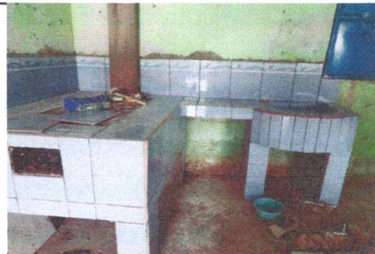
Foto No. 10 Sustitución de estufa y mesa en cocina con azulejo
