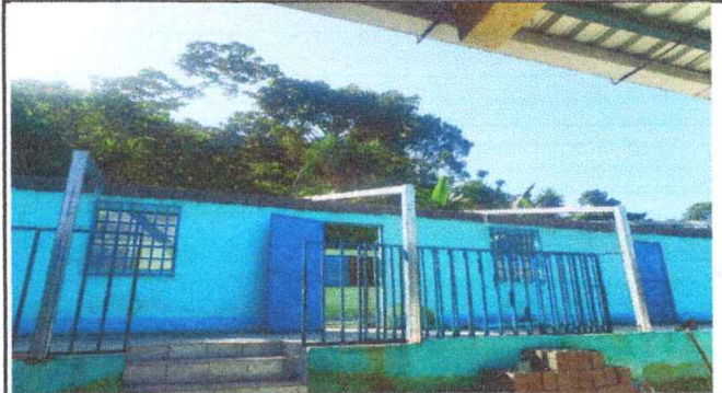
Foto No.2 Sustrucción de estructura portante con estructura metálica galvanizada.
