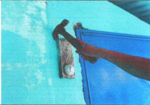
Foto No. 7 Sustitución de interruptores
