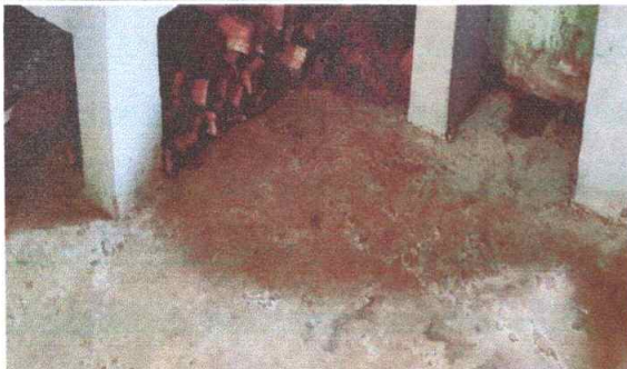
No.11 Sustitucion de piso con cerámico en cocina
