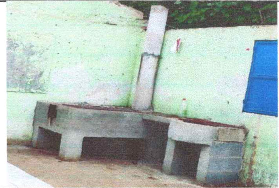
No.10 Sustitucion de estufa y mesa en cocina con azulejo
