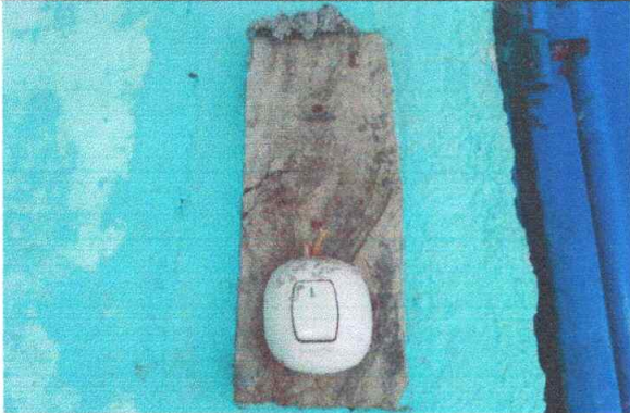
No.7 Sustitucion de interruptores
