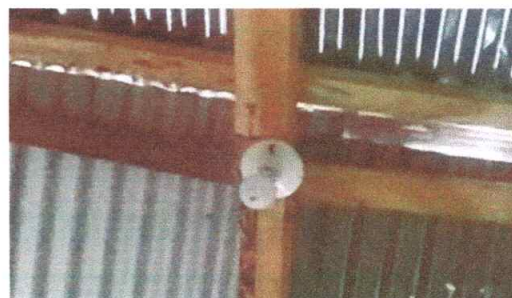
No.6 Sustitucion de lumincarias de 30 whats
