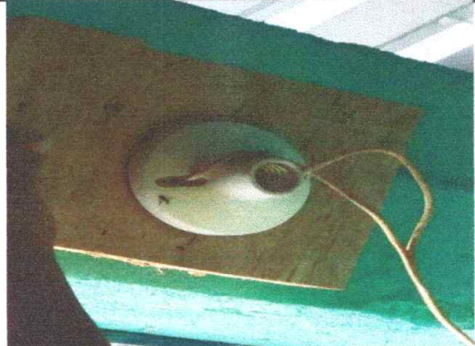
No.8 Sustitucion de plafoneras
