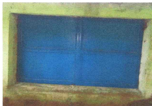
No.4 sustitucion de balcones en ventanas de metal
