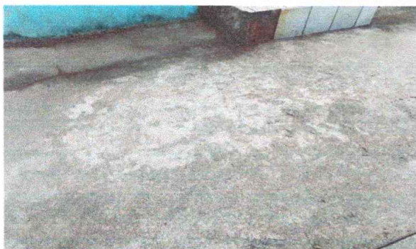
No.3 Sustitución de torta de concreto
