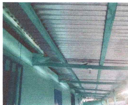
No.2 Sustitución de estructura portante con estructura metalica galvanizada
