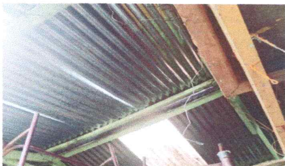
No.1 Sustitucion de cubierta metalica
