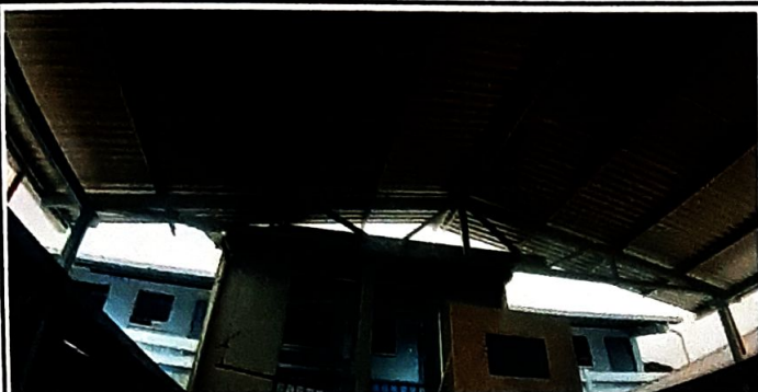
No.1 SUSTITUCIÓN DE ESTRUCTURA EXISTENTE A ESTRUCTURA METALICA
