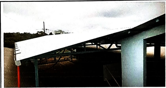
No.4 SUSTITUCIÓN DE CUBIERTA METALICA CON LAMINA TROQUELADA CALIBRE 26 CON ALUZINC
