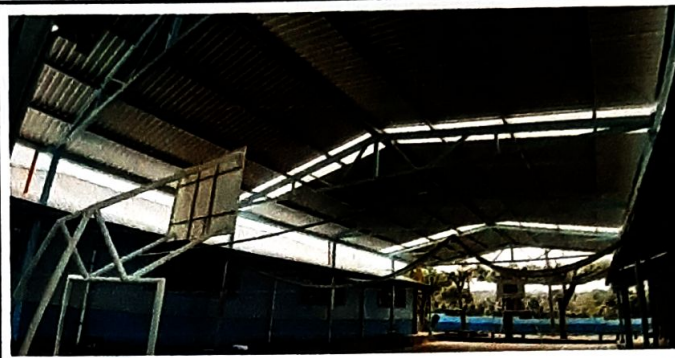
No.2 SUSTITUCIÓN DE JOIST DE ESTRUCTURA PORTANTE
