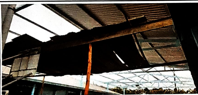
No.3 SUSTITUCIÓN DE ESTRUCTURA PORTANTE EXISTENTE A ESTRUCTURA PORTANTE METÁLICA
