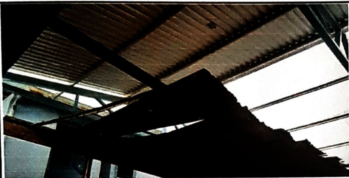
Foto1: SUSTITUCION DE ESTRUCTURA EXISTENTE A ESTRUCTURA METALICA
