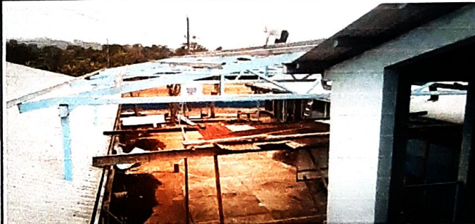
No.4 SUSTITUCIÓN DE CUBIERTA METALICA CON LAMINA TROQUELADA CALIBRE 26 CON ALUZINC
