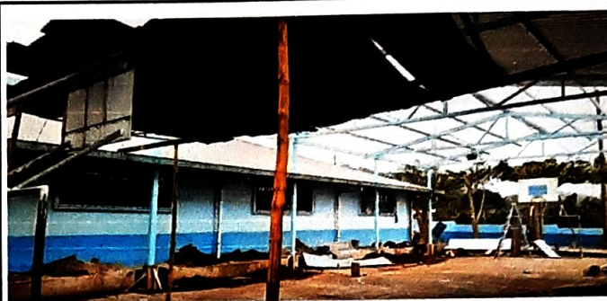
No.2 SUSTITUCIÓN DE JOIST DE ESTRUCTURA PORTANTE
