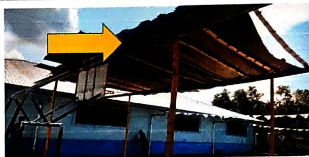
No.2 SUSTITUCIÓN DE JOIST DE ESTRUCTURA PORTANTE
