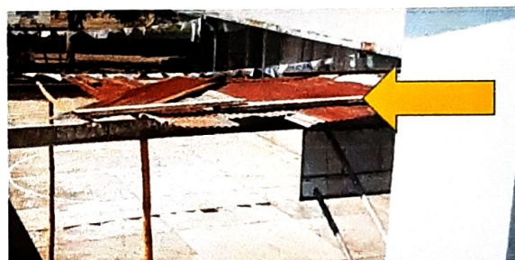
No.4 SUSTITUCIÓN DE CUBIERTA METALICA CON LAMINA TROQUELADA CALIBRE 26 CON ALUZINC
