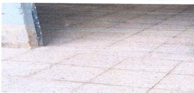
SUSTITUCIÓN DE PISO CERÁMICO AULA 1 MODULO 2
