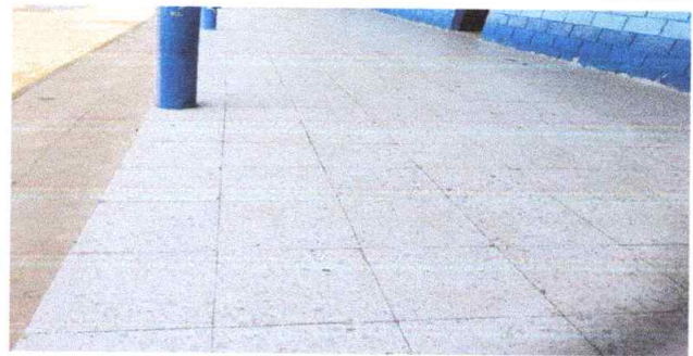
SUSTITUCIÓN DE PISO CERÁMICO DEL CORREDOR DE MÓDULO 1
