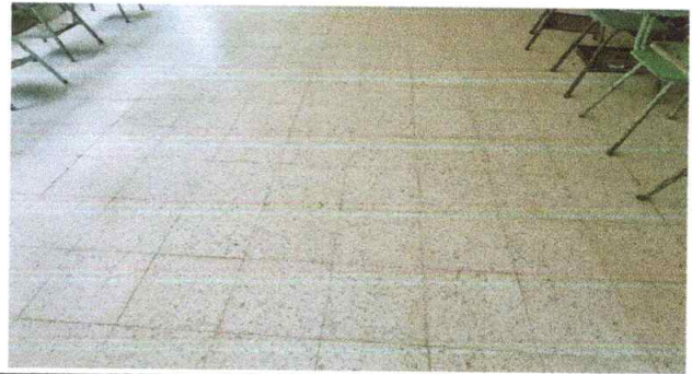
SUSTITUCIÓN DE PISO CERAMICO AULA 2 DEL MÓDULO 1
