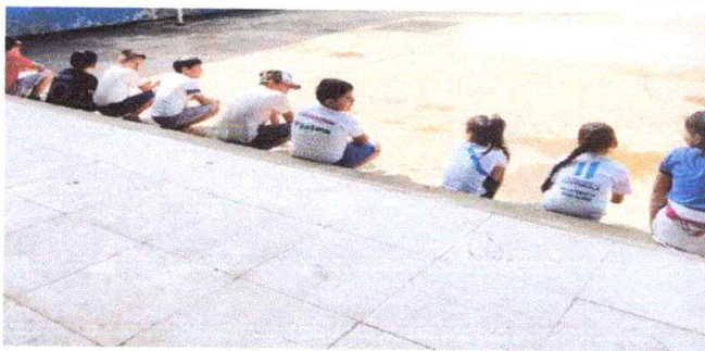
SUSTITUCIÓN DE PISO CERÁMICO DEL CORREDOR MÓDULO 1
