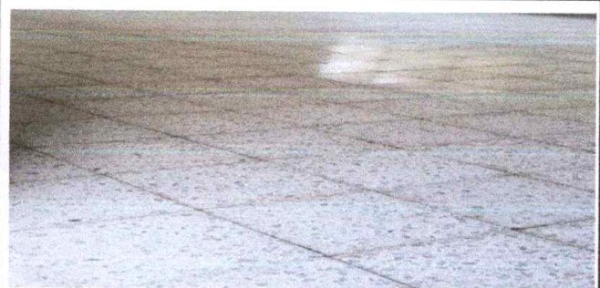
SUSTITUCIÓN DE PISO CERÁMICO DEL CORREDOR MÓDULO 2
