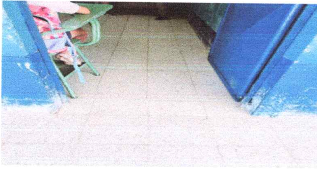
SUSTITUCIÓN DE PISO CERÁMICO AULA 1 DEL MÓDULO 1
