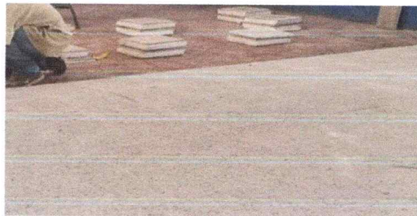
SUSTITUCIÓN DE PISO CERÁMICO AULA 2 DEL MÓDULO 1
