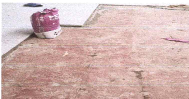
SUSTITUCIÓN DE PISO CERÁMICO DEL CORREDOR MÓDULO 2
