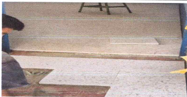
SUSTITUCIÓN DE PISO CERÁMICO AULA 1 DEL MÓDULO 1
