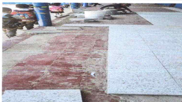
SUSTITUCIÓN DE PISO CERÁMICO DEL CORREDOR DE MÓDULO 1
