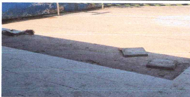
SUSTITUCIÓN DE PISO CERÁMICO DEL CORREDOR MÓDULO 1
