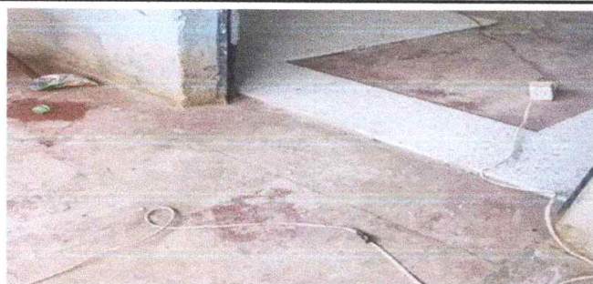
SUSTITUCIÓN DE PISO CERÁMICO AULA 1 MÓDULO 2
