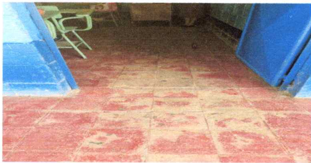
SUSTITUCIÓN DE PISO CERÁMICO AULA 1 DEL MÓDULO 1
