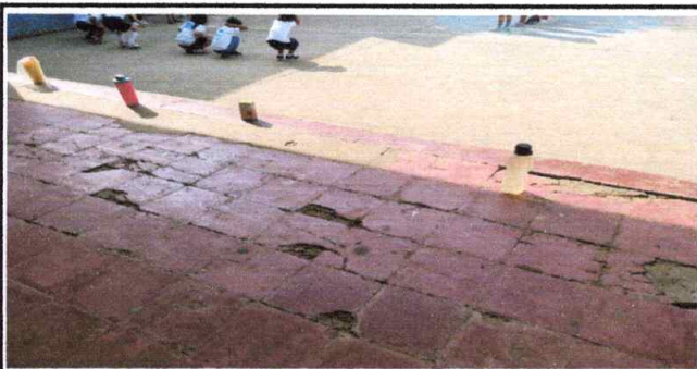
SUSTITUCIÓN DE PISO CERÁMICO DEL CORREDOR MÓDULO 1
