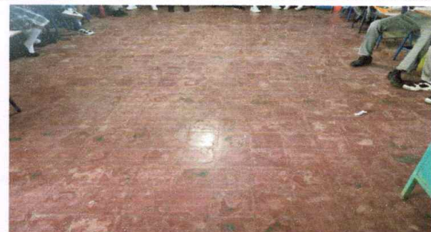
SUSTITUCIÓN DE PISO CERAMICO AULA 2 DEL MÓDULO 1
