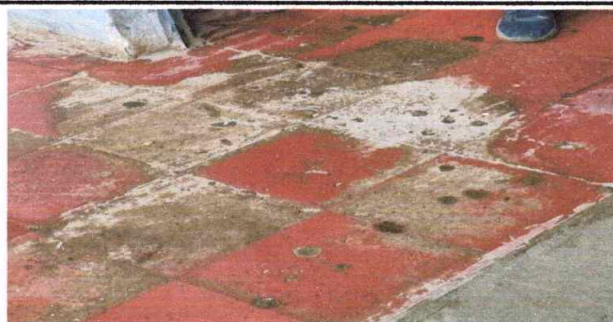
SUSTITUCIÓN DE PISO CERÁMICO AULA 1 MODULO 2
