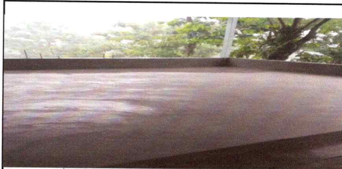
SUSTITUCIÓN DE PISO DE CONCRETO EN PARTE FRONTAL DE LA ENTRADA PRINCIPAL.
