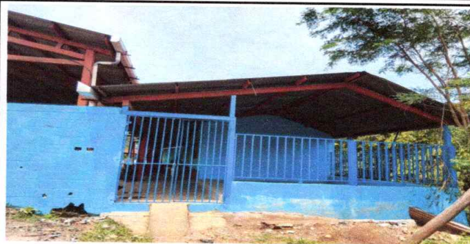
SUSTITUCION DE MURO DE MAMPOSTERIA CON BARANDALES TIPO REJA EN AULA MODULO No. 1 ENTRADA PRINCIPAL.
