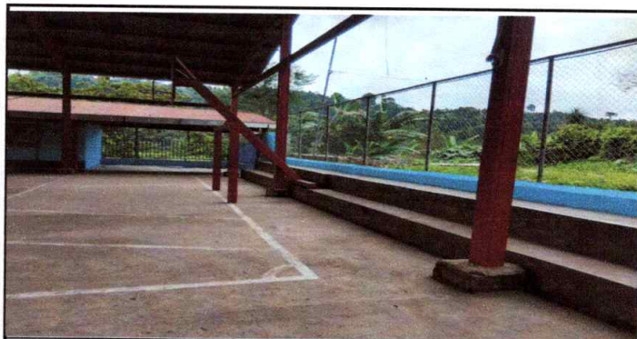
SUSTITUCION DE MURO PERIMETRAL CON TUBOS GALVANIZADOS DIAMETRO DE 2 PULGADAS MAS MALLA PERIMETRAL No. 2
