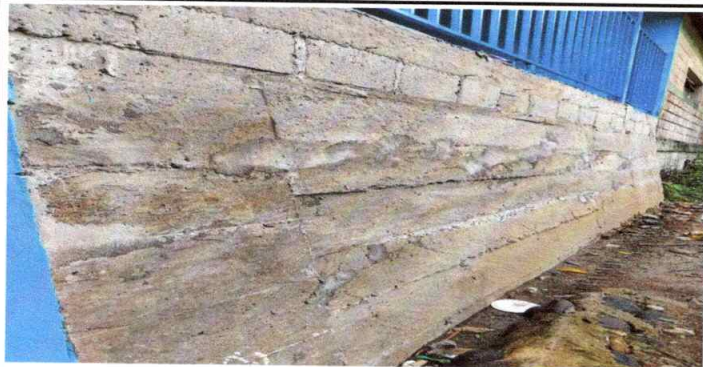
REPARACION DE MURO DE CONTENCIÓN DE CONCRETO EN PARTE FRONTAL Y LATERAL DEL ESTABLECIMIENTO.
