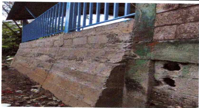
REPARACIÓN DE MURO DE CONTENCIÓN DE CONCRETO EN PARTE FRONTAL Y LATERAL DEL ESTABLECIMIENTO
