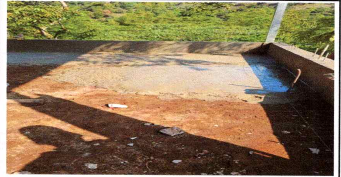
SUSTITUCION DE PISO DE CONCRETO EN PARTE FRONTAL DE LA ENTRADA PRINCIPAL.
