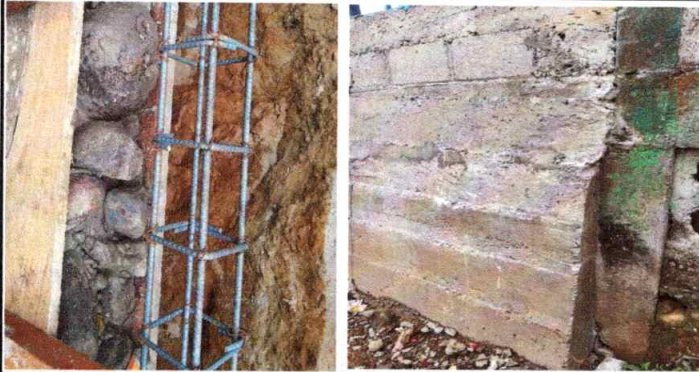
REPARACION EN MURO DE CONTENCIÓN DE CONCRETO EN PARTE FRONTAL Y LATERAL DEL ESTABLECIMIENTO.
