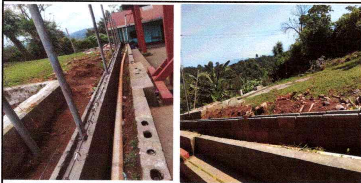
SUSTITUCION DE MURO PERIMETRAL CON TUBOS GALVANIZADOS DIAMETRO DE 2 PULGADAS MAS MALLA PERIMETRAL No. 2
