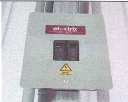
No.7 sustitución de cableado electrico No. 10 en cocina
