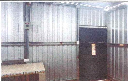
No.1 sustitución de bases y estructura de soportes verticales
