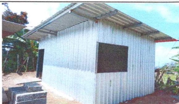
No.2 sustitución de lámina acanalada en muros de cocina
