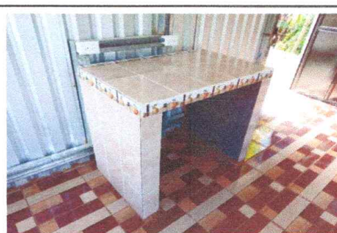
No.12 sustitución de azulejo en mesa de concreto de cocina
