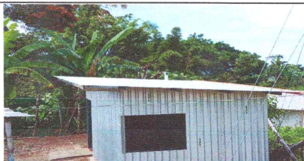
No.3 sustitución de estructura portante con estructura metalica y de lamina acanalada por lamina troquelada en cubierta metalica
