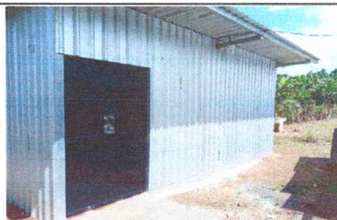
No.6 sustitución de puerta metalica en cocina de 1.0 m * 2.0 m
