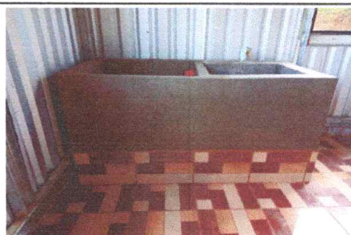
No.10 sustitución de pila de concreto
