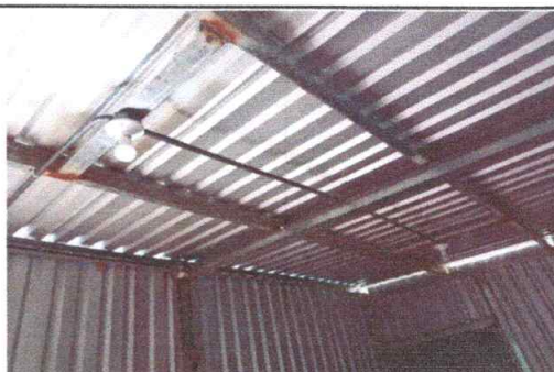
No.8 sustitución de luminarias y tomacorrientes en cocina
