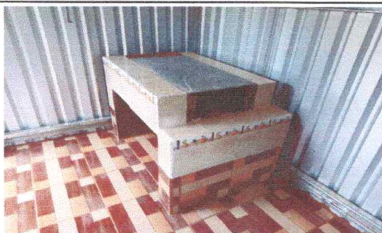
No.9 sustitución de estufa de adobe en cocina
