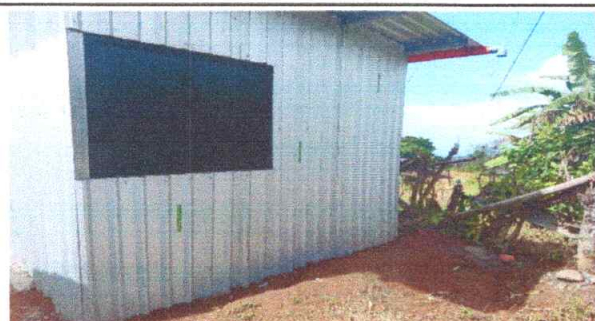
No.5 sustitución de ventanas metalicas en cocina de 1.20 m * 1.0 m con pasadores
