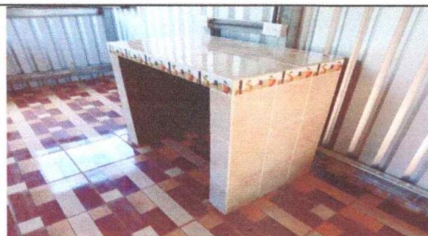
No.11 sustitución de mesa de concreto en cocina
