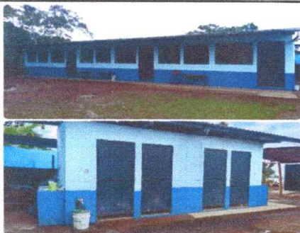
No.13 mantenimiento preventivo de pintura en muros interiores y exteriores
