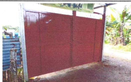
No.14 sustitución de portón metálico en ingreso principal
