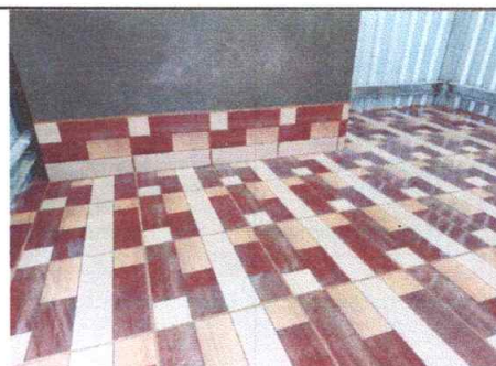
No.4 sustitución de torta de concreto en cocina más piso ceramico
