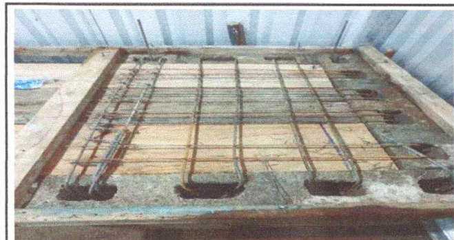
No.11 sustitución de mesa de concreto en cocina
