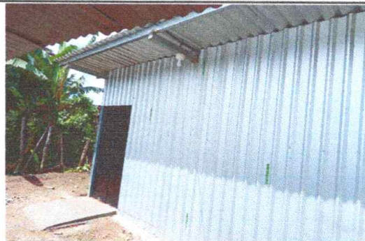
No.2 sustitución de lámina acanalada en muros de cocina
