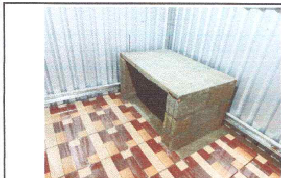
No.9 sustitución de estufa de adobe en cocina
