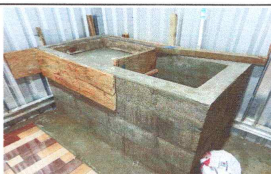
No.10 sustitución de pila de concreto
