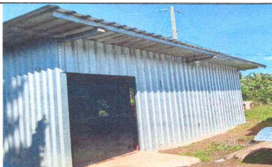
No.6 sustitución de puerta metálica en cocina de 1.0 m * 2.0 m
