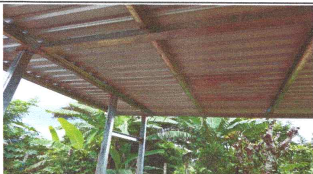
No.3 sustitución de estructura portante con estructura metálica y de lámina acanalada por lámina troquelada en cubierta metálica
