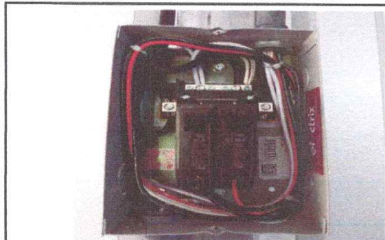
No.7 sustitución de cableado electrico No. 10 en cocina
