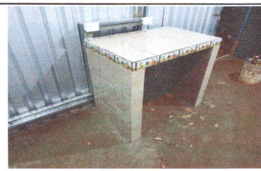
No.12 sustitución de azulejo en mesa de concreto de cocina
