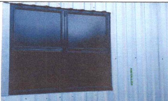
No.5 sustitución de ventanas metálicas en cocina de 1.20 m * 1.0 m con pasadores
