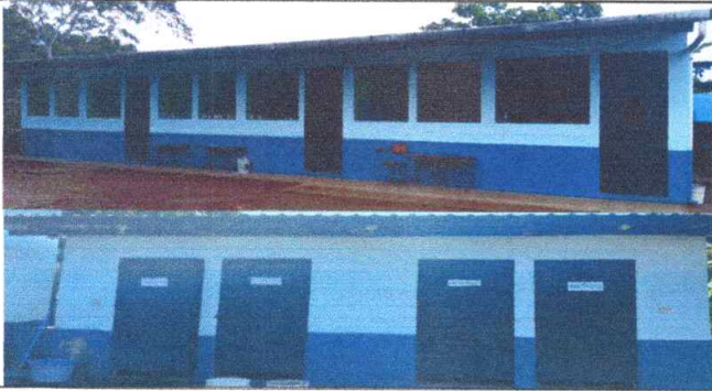
No.13 mantenimiento preventivo de pintura en muros interiores y exteriores
