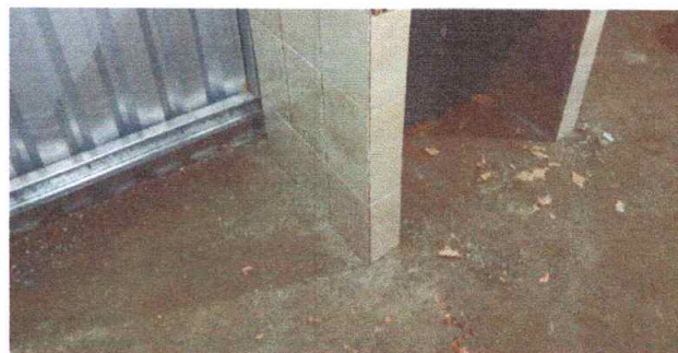
No.4 sustitución de torta de concreto en cocina más piso cerámico
