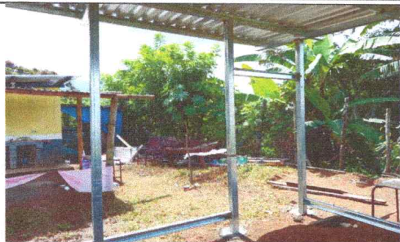
No.1 sustitución de bases y estructura de soportes verticales
