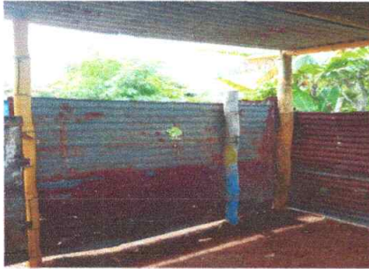
No.1 sustitución de bases y estructura de soportes verticales
