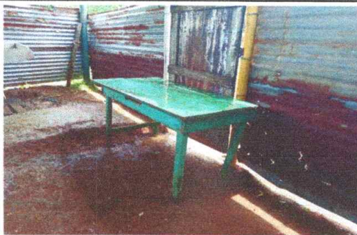
No.11 sustitución de mesa de concreto en cocina
