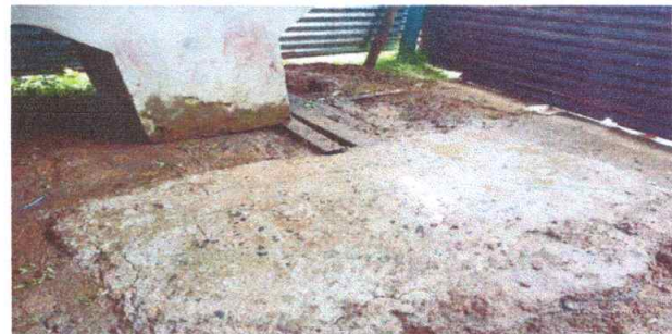
No.4 sustitución de torta de concreto en cocina más piso ceramico
