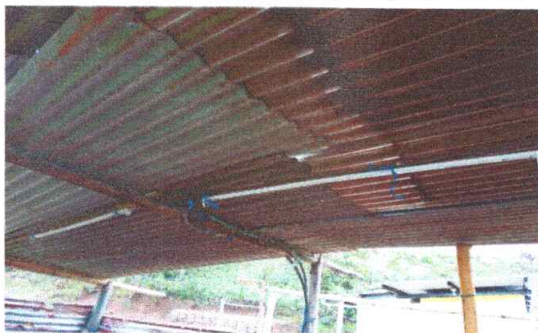
No.7 sustitución de cableado eléctrico No. 10 en cocina
