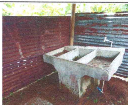
No.10 sustitución de pila de concreto
