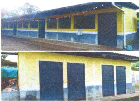
No.13 mantenimiento preventivo de pintura en muros interiores y exteriores
