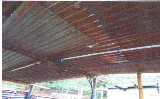
No.8 sustitución de luminarias y tomacorrientes en cocina
