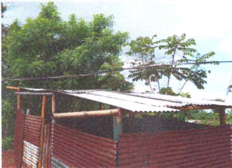
No.3 sustitución de estructura portante con estructura metalica y de lamina acanalada por lamina troquelada en cubierta metalica
