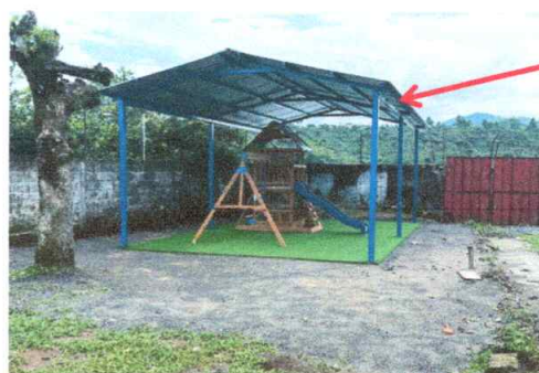
SUSTITUCIÓN DE LÁMINA POR LÁMINA TROQUELADA ALUZINC CALIBRE 26 EN ÁREA DE JUEGOS.
