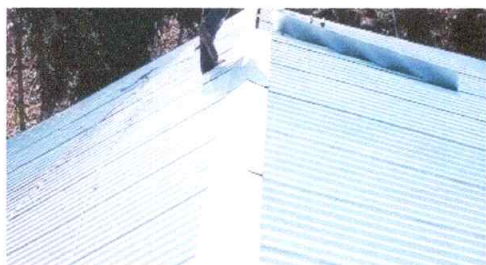
SUSTITUCIÓN DE CAPOTE DE LÁMINA EN ÁREA DE JUEGOS.
