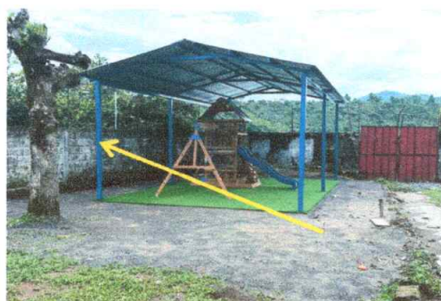
SUSTITUCIÓN DE ESTRUCTURA DE SOPORTE MADERA POR METAL EN ÁREA DE JEGOS.
