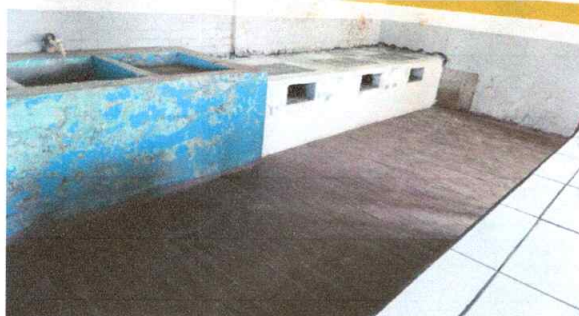
SUSTITUCIÓN DE PISO CERÁMICO EN COCINA.
