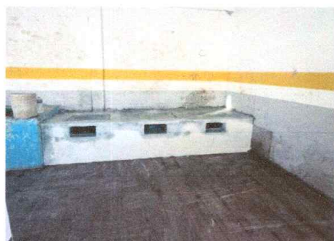
SUSTITUCIÓN DE ESTUFA RURAL COMPLETA P/3 PERSONAS EN COCINA INCLUYE CHIMENEA Y PLANCHA DE METAL.
