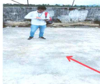
SUSTITUCIÓN DE PISO DE CONCRETO EN ÁREA DE JUEGOS.
