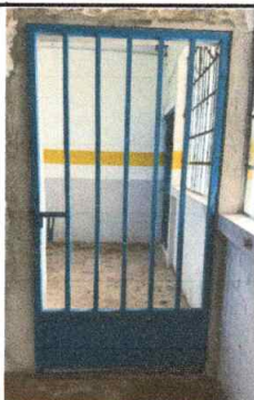
SUSTITUCIÓN DE PUERTA DE MADERA EN METAL DE COCINA.
