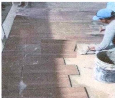
SUSTITUCIÓN DE PISO CERÁMICO EN COCINA.
