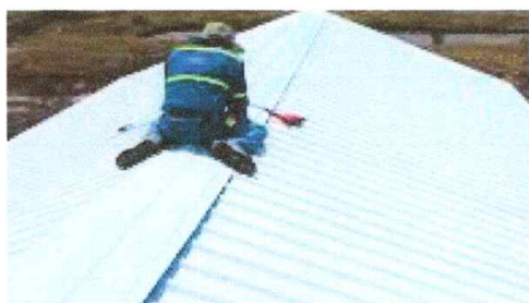
SUSTITUCIÓN DE CAPOTE DE LÁMINA EN ÁREA DE JUEGOS.
