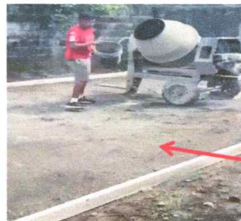
SUSTITUCIÓN DE PISO DE CONCRETO EN ÁREA DE JUEGOS.
