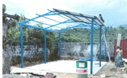
SUSTITUCIÓN DE LÁMINA POR LÁMINA TROQUELADA ALUZINC CALIBRE 26 EN ÁREA DE JUEGOS.
