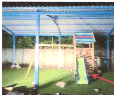
SUSTITUCIÓN DE JUEGOS INFANTILES TOBOGAN PVC, ESCALERAS MÁS ACCESORIOS DE MADERA.
