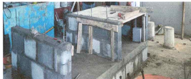
SUSTITUCIÓN DE MEZÓN DE PREPARACIÓN AZULEJEADO EN COCINA.
