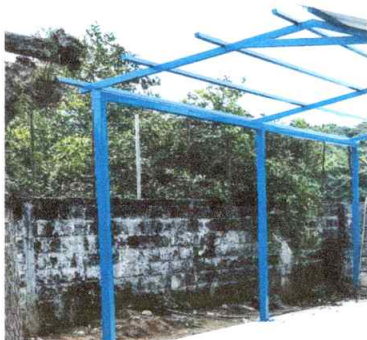
SUSTITUCIÓN DE ESTRUCTURA DE SOPORTE MADERA POR METAL EN ÁREA DE JEGOS.
