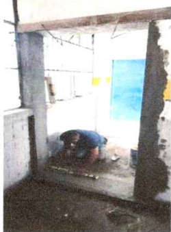
SUSTITUCIÓN DE PUERTA DE MADERA EN METAL DE COCINA.
