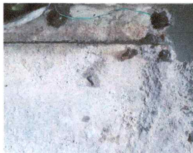
SUSTITUCIÓN DE PISO DE CONCRETO EN AREA DE JUEGOS
