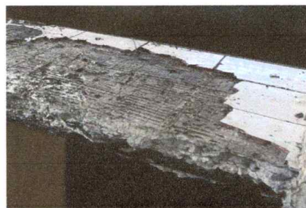
SUSTITUCIÓN DE MEZON DE PREPARACIÓN AZULEJEADO EN COCINA
