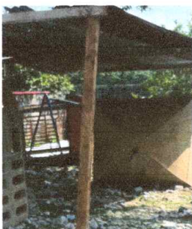
SUSTITUCIÓN DE ESTRUCTURA DE SOPORTE MADERA POR METAL EN AREA DE JUEGOS
