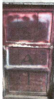
SUSTITUCIÓN DE PUERTA DE MADERA POR METAL EN COCINA
