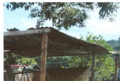
SUSTITUCIÓN DE LAMINA POR LAMINA TROQUELADA ALUZINC CALIBRE 26 EN AREA DE JUEGOS
