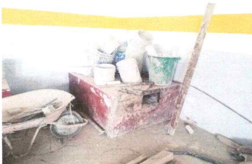
SUSTITUCIÓN DE ESTUFA RURAL COMPLETA P/3 PERSONAS EN COCINA INCLUYE CHIMENEA Y PLANCHA DE METAL
