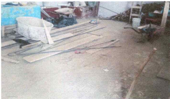
SUSTITUCIÓN DE PISO CERAMICO EN COCINA
