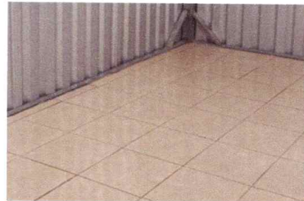
SUSTITUCION DE FIRME DE CONCRETO
