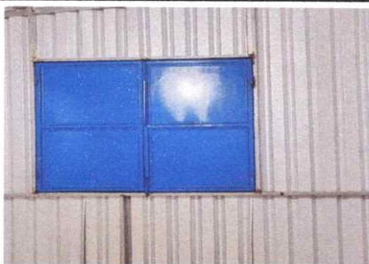
INSTALACION DE VENTANA DE METAL
