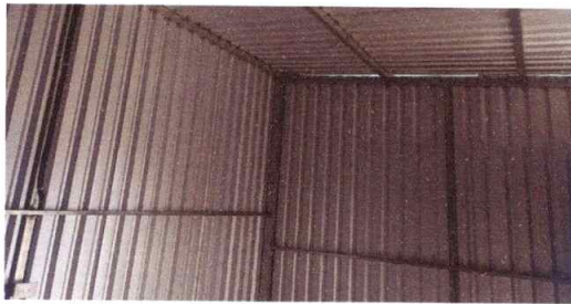
SUSTITUCION DE ESTRUCTURA PORTANTE POR ESTRUCTURA METALICA.
