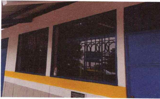
MANTENIMIENTO A BALCONES
