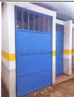
SUSTITUCION DE PUERTA DE BODEGA
