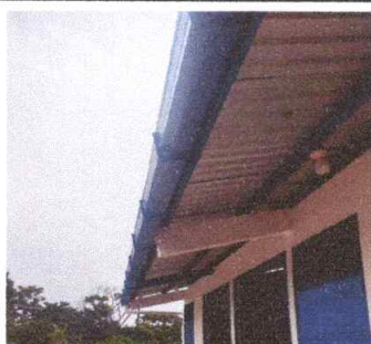
SUSTITUCION DE CANAL PLUVIAL
