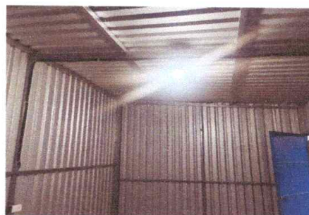
SUSTITUCION SISTEMA ELECTRICO
