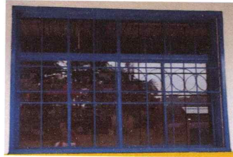
MANTENIMIENTO A VENTANALES
