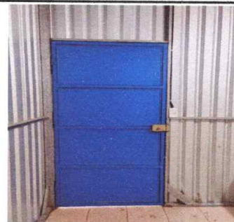
SUSTITUCION DE PUERTA
