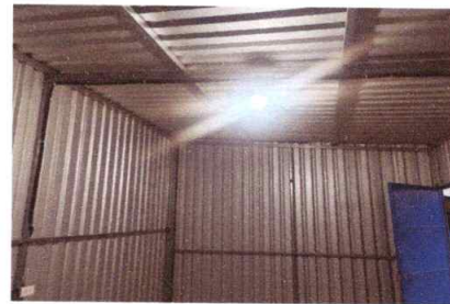
SUSTITUCION DE CUBIERTA METALICA
