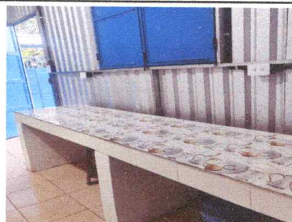
REPARACION DE MESA DE CONCRETO
