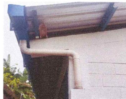
SUSTITUCION DE BAJADAS PLUVIALES
