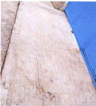
REPARACION DE BANQUETA EXTERIOR
