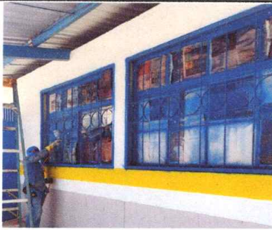
MANTENIMIENTO A BALCONES
