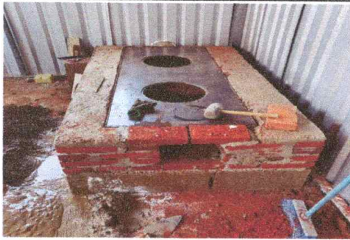
SUSTITUCION DE ESTUFA
