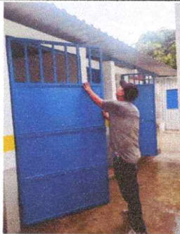
SUSTITUCION DE PUERTA DE BODEGA
