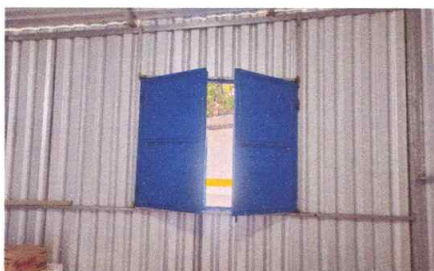
INSTALACION DE VENTANA DE METAL
