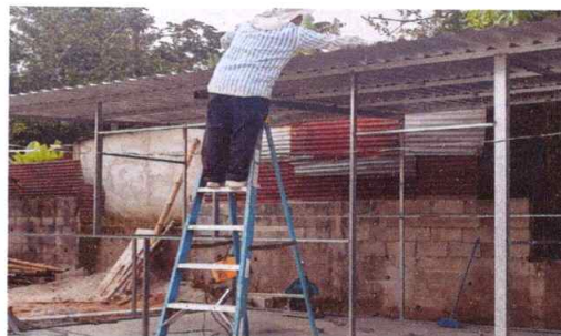
SUSTITUCION DE CUBIERTA METALICA
