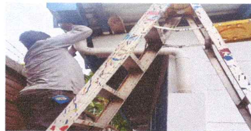
SUSTITUCION DE BAJADAS PLUVIALES
