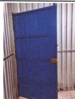
SUSTITUCION DE PUERTA
