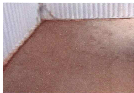
SUSTITUCION DE FIRME DE CONCRETO
