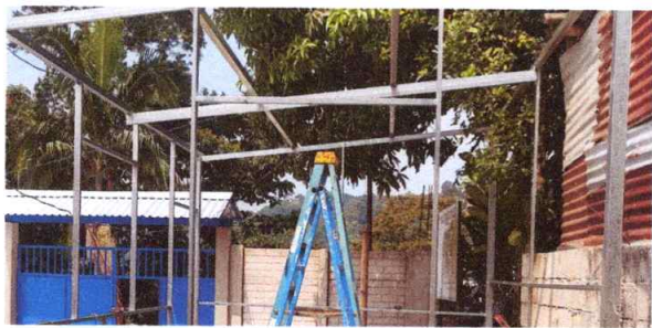
SUSTITUCION DE ESTRUCTUTURA PORTANTE POR ESTRUCTRA METALICA.
