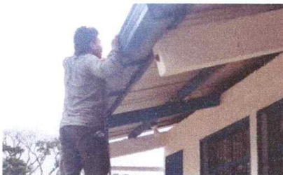
SUSTITUCION DE CANAL PLUVIAL
