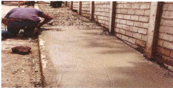
REPARACION DE BANQUETA EXTERIOR
