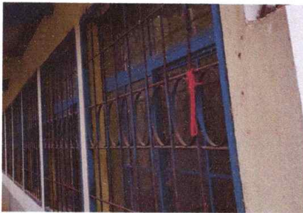
MANTENIMIENTO A BALCONES
