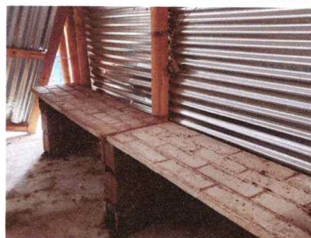
REPARACION DE MESA DE CONCRETO
