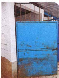
SUSTITUCION DE PUERTA DE BODEGA
