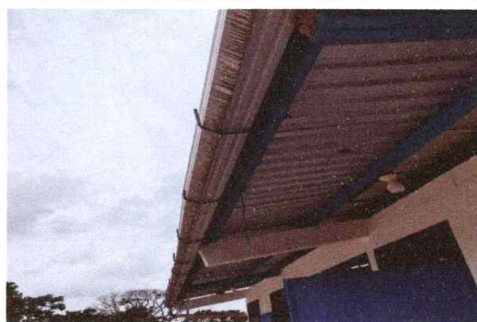
SUSTITUCION DE CANAL PLUVIAL
