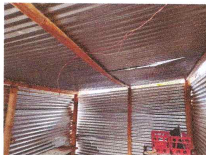
SUSTITUCION DE CUBIERTA METALICA
