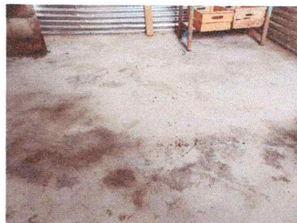
SUSTITUCION DE FIRME DE CONCRETO
