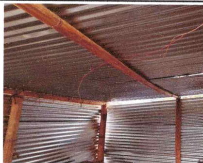
SUSTITUCION SISTEMA ELECTRICO
