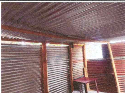
INSTALACION DE VENTANA DE METAL
