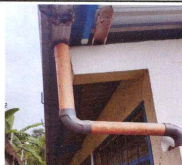
SUSTITUCION DE BAJADAS PLUVIALES
