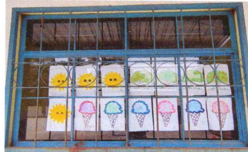
MANTENIMIENTO A VENTANALES
