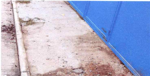
REPARACION DE BANQUETA EXTERIOR
