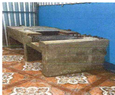
Sustitucion de estufa de ladrillo en cocina
