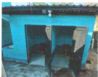
Sustitución de tazas sanitarias
