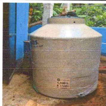
Sustitucion de tanque cisterna rotoplas de capacidad de 1100 litros
