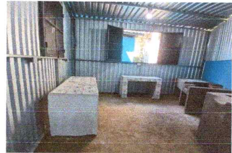
Sustitucion de ventanas metalicas en cocina con pasadores
