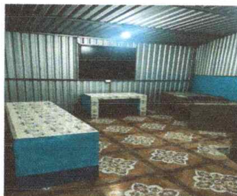
Sustitución de azulejo en mesa de concreto
