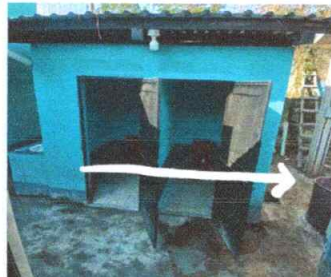
Sustitución de tubería de drenaje
