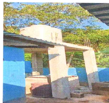
Sustitucion de bomba hidraulica + instalacion
