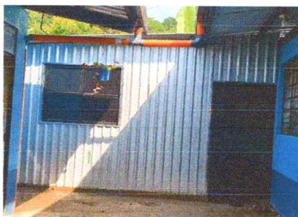
Sustitucion de lamina troquelada aluzin calibre 26 en cubierta de cocina
