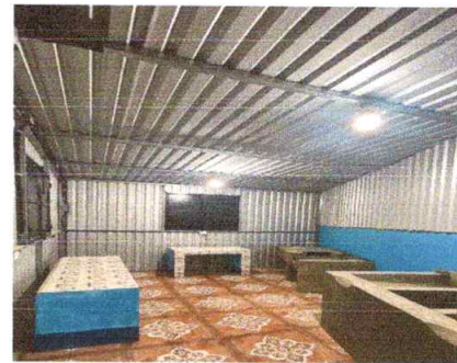
Sustitucion de instalaciones electricas en iluminacion y fuerza
