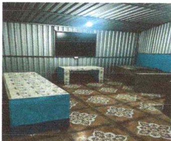
Sustitución de mesa de concreto en cocina
