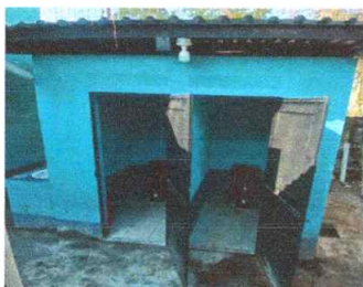
Mantenimiento a muros de servicio sanitario con aplicación de pintura
