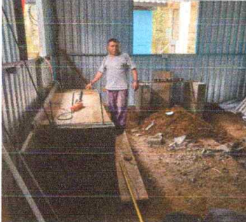
Sustitucion de mesa de concreto en cocina
