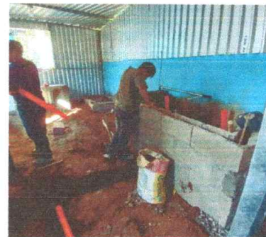
Sustitucion de pila de concreto de dos lavadores en cocina de 1*2m
