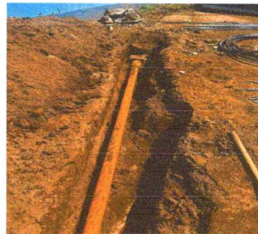
Sustitucion de tuberia de drenaje
