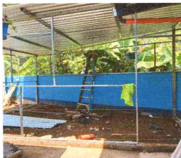
Sustitucion de lamina troquelada aluzin calibre 26 en cubierta de cocina
