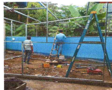
Sustitucion de estructura de madera a metalica de cocina
