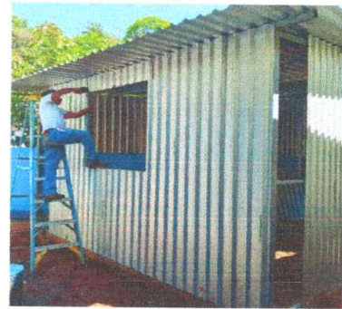
Sustitucion de ventanas metalicas en cocina con pasadores
