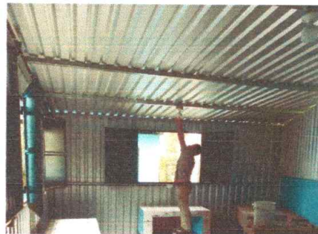
Sustitucion de instalaciones electricas en iluminacion y fuerza
