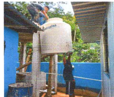
Sustitucion de tanque cisterna rotoplas de capacidad de 1100 litros
