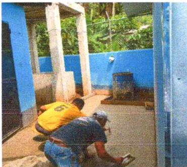
Sustitucion de losa concreto para rotoplas en base de rotoplas y piso de cocina
