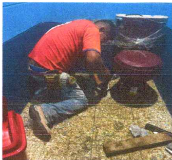
Sustitucion de tazas sanitarias
