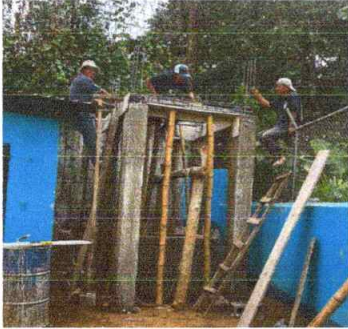
Sustitucion de brocal para pozo de agua
