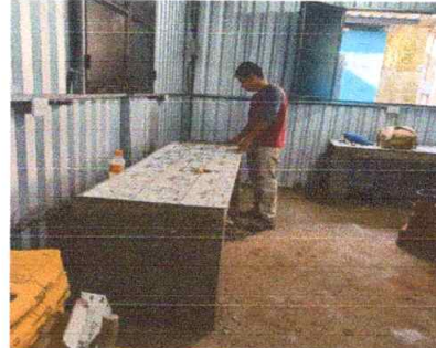
Sustitucion de azulejo en mesa de concreto
