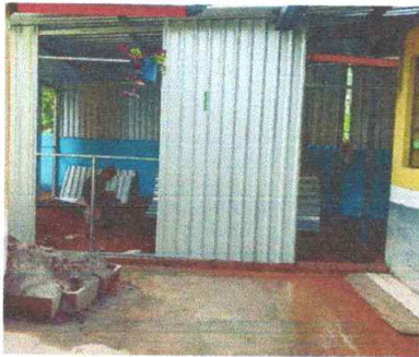
Sustitucion de lamina de troquelada aluzin calibre 26 para muros de cocina
