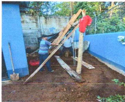
Sustitucion de brocal para pozo de agua
