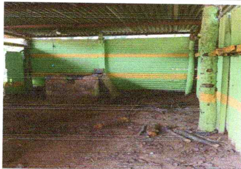
Sustitucion de lamina de troquelada aluzin calibre 26 para muros de cocina
