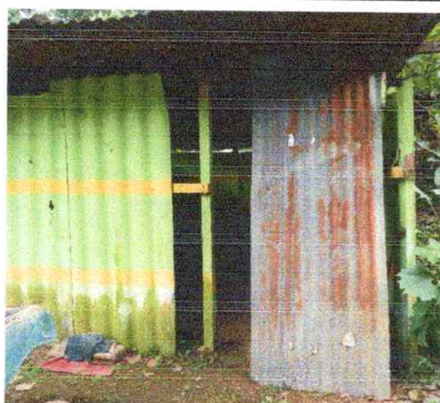
Sustitucion de puerta metalica en cocina 1*2 chapa yale
