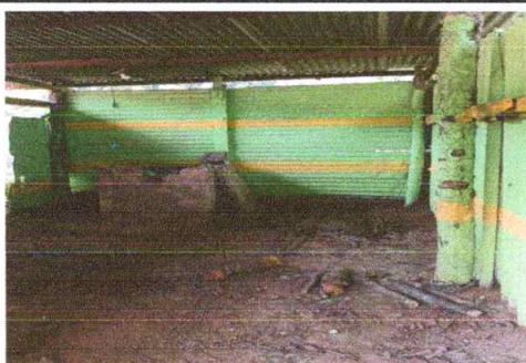
Sustitucion de lamina troquelada aluzin calibre 26 en cubierta de cocina
