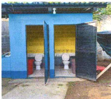
Sustitucion de tazas sanitarias
