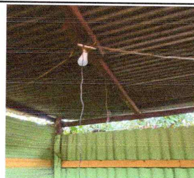
Sustitucion de instalaciones electricas en iluminacion y fuerza
