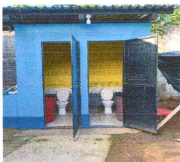
Mantenimiento a muros de servicio sanitario con aplicación de pintura
