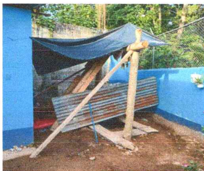
Sustitucion de losa concreto para rotoplas en base de rotoplas y piso de cocina
