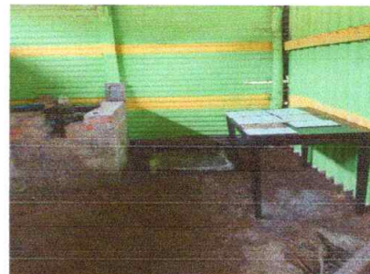
Sustitucion de azulejo en mesa de concreto
