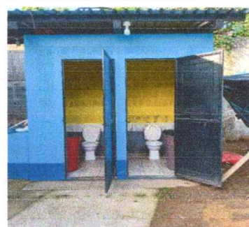
Sustitucion de tuberia de drenaje
