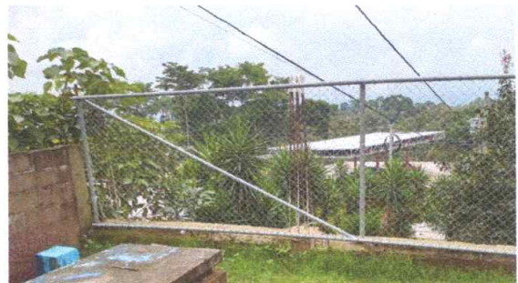
Sustitución de cerca en muro perimetral con tubo y malla galvanizada.
