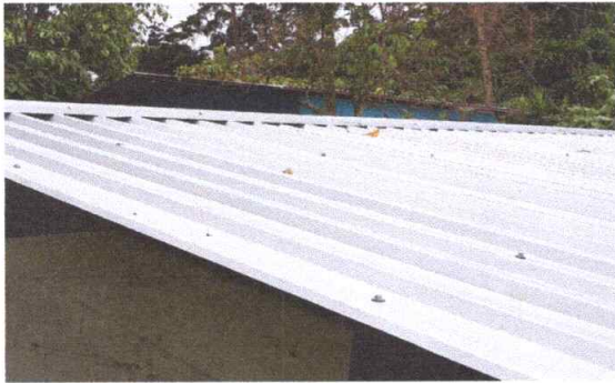
Sustitución de lámina troquelada Calibre 26 en las aulas 1,2 y 3 del centro educativo
