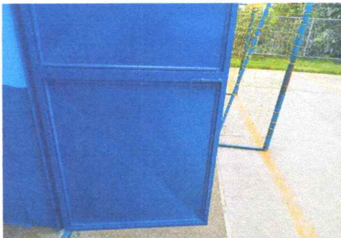
Mantenimiento en puertas metálicas de las aulas 1,2 y 3; de los sanitarios 1,2,3 y 4; cocina 1.
