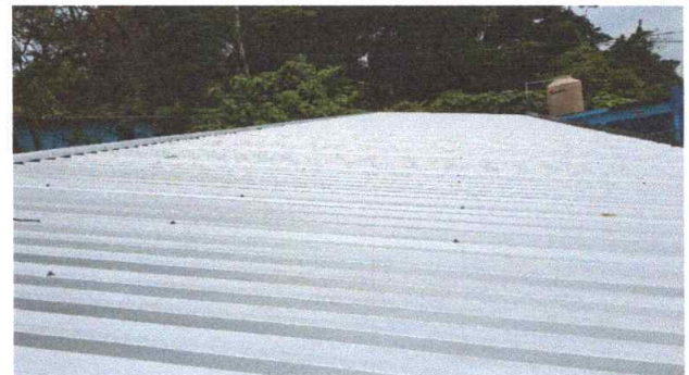
Sustitución de lámina troquelada Calibre 26 en las aulas 1,2 y 3 del centro educativo
