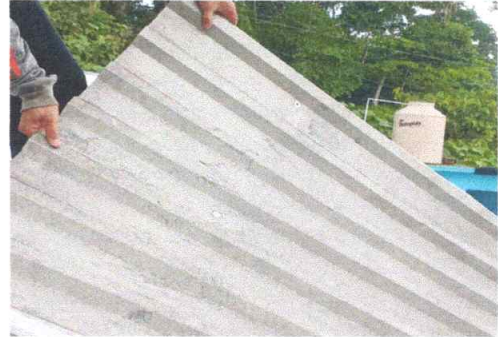
Sustitución de lámina troquelada Calibre 26 en las aulas 1,2 y 3 del centro educativo
