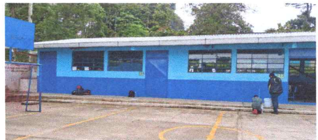
Mantenimiento de pintura en interior y exterior del edificio escolar.
