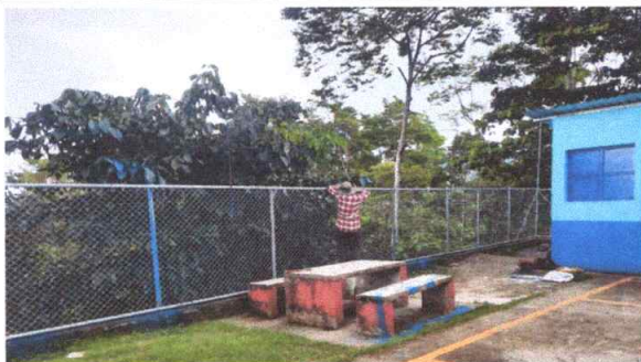
Sustitución de cerca en muro perimetral con tubo y malla galvanizada.
