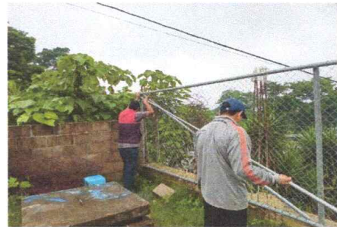
Sustitución de cerca en muro perimetral con tubo y malla galvanizada.
