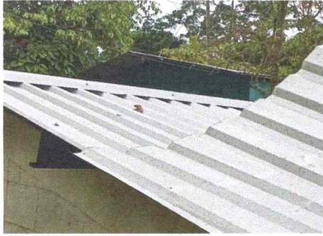
Sustitución de lámina troquelada Calibre 26 en las aulas 1,2 y 3 del centro educativo
