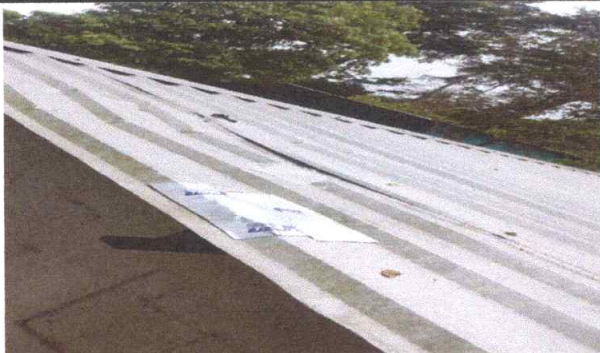
Sustitución de lámina troquelada Calibre 26 en las aulas 1,2 y 3 del centro educativo
