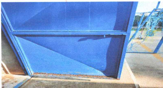
Mantenimiento en puertas metálicas de las aulas 1,2 y 3; de los sanitarios 1,2,3 y 4; cocina 1.
