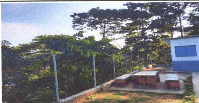
Sustitución de cerca en muro perimetral con tubo y malla galvanizada.
