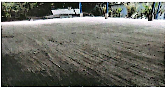
No.1 Mantenimiento y sustitución de de patio de tierra a piso de concreto
