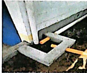
No. 7 Sustitución de tubería en pvc de 4 pulgada en sistema de drenaje y grifo
