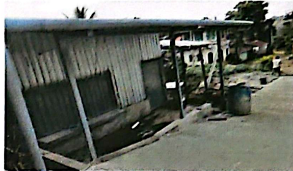
No. 2 Sustitución de estructura de madera por estructura metálica en cocina
