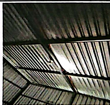
No.6 Sustitución de entubado y sistema eléctrico
