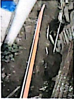
No. 7 Sustitución de tubería en pvc de 4 pulgada en sistema de drenaje y grifo
