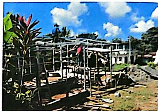
No. 2 Sustitución de estructura de madera por estructura metálica en cocina
