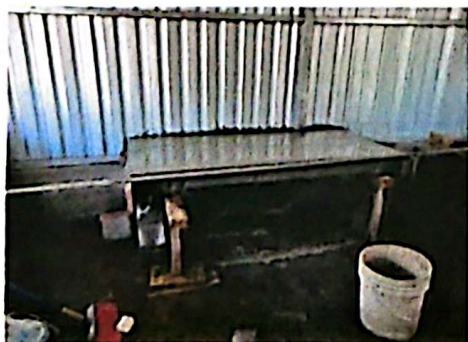
No.5 Sustitución de mesa de trabajo de concreto en cocina
