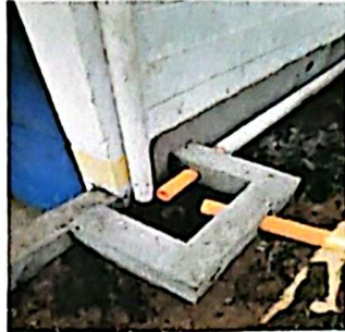
No. 7 Sustitución de tubería en pvc de 4 pulgada en sistema de drenaje y grifo
