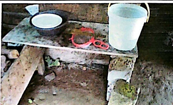
No.5 Sustitución de mesa de trabajo de concreto en cocina
