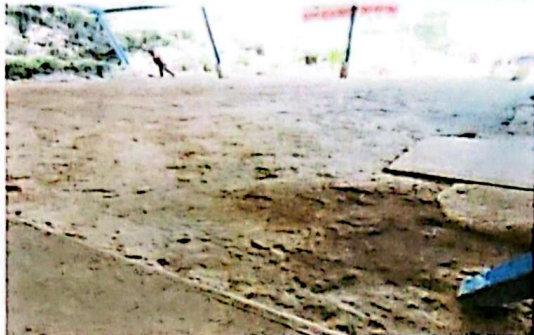
No.1 Mantenimiento y sustitución de de patio de tierra a piso de concreto
