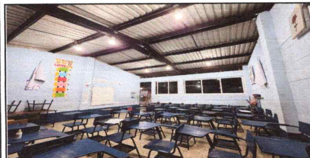
Foto 5: Sustitución de Sistema Eléctrico
