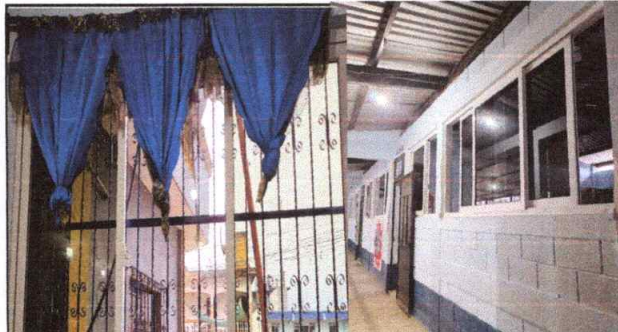
Foto 2: Sustitución de ventanas En aula 1,2,3,4,5 y 6.
