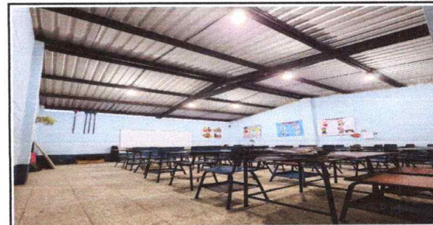
Foto 5: Sustitución de Sistema Eléctrico
