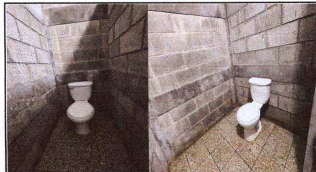
Foto 4: Mantenimiento de Servicios Sanitarios y Accesorios.
