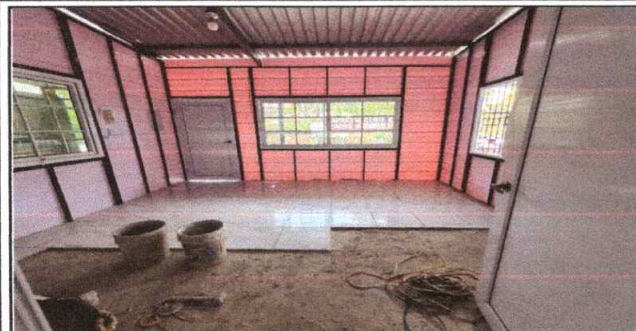
Foto1: Sustitución de piso cerámico 30X30 cm. En aula No. 7
