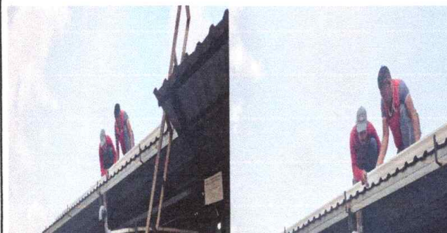
Foto 3: Sustitución de canales y bajadas de agua pluvial de UPVC.
