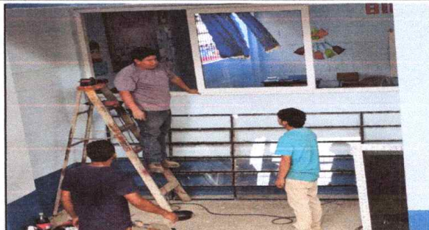
Foto 2: Sustitución de Ventanas UPVC en aula 1,2,3,4,5 y 6
