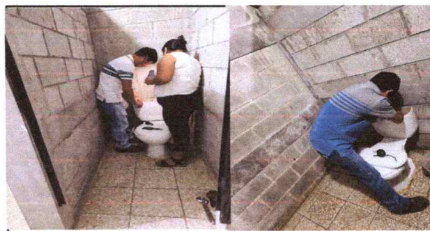
Foto 4: Mantenimiento de Servicios Sanitarios y Accesorios.
