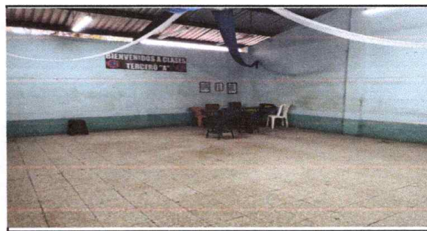
Foto 5: Sustrucción de sistema eléctrico
