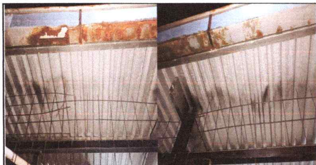
Foto 3: Sustrucción de canales y bajadas de agua pluvial de UPVC.
