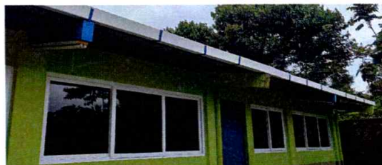
SUSTITUCION DE CANAL PLUVIAL
