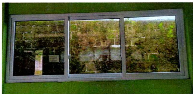
SUSTITUCION DE VENTANA
