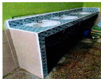
REPARACION DE MESA DE LAVAMANOS
