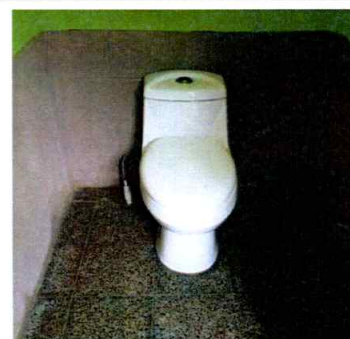
SUSTITUCION DE TAZA SANITARIA
