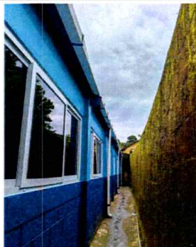
MANTENIMIENTO A PARED EXTERIOR DE MODULO DE AULAS
