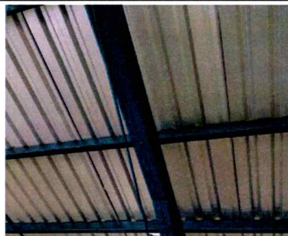
SUSTITUCION DE CUBIERTA METALICA
