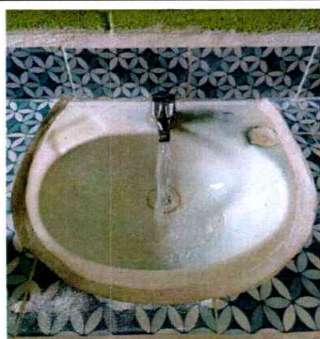
SUSTITUCION DE GRIFOS DE LAVAMANOS
