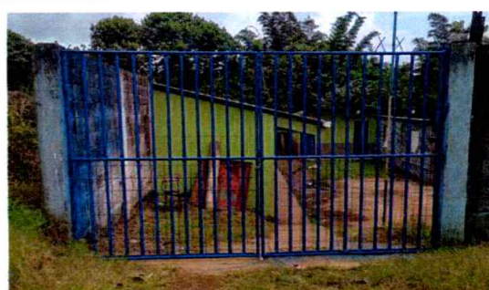
MANTENIMIENTO A PORTON
