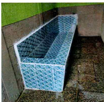
REPARACION DE URINARIO
