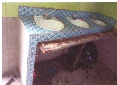
REPARACION DE MESA DE LAVAMANOS
