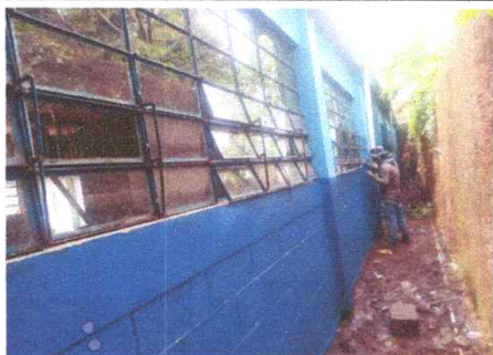
MANTENIMIENTO A PARED EXTERIOR DE MODULO DE AULAS
