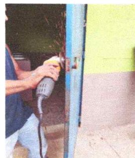
SUSTITUCION DE CHAPA
