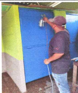
MANTENIMIENTO A PUERTAS DE AULAS Y BAÑO
