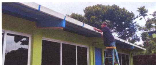
SUSTITUCION DE CANAL PLUVIAL
