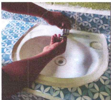
SUSTITUCION DE GRIFOS DE LAVAMANOS
