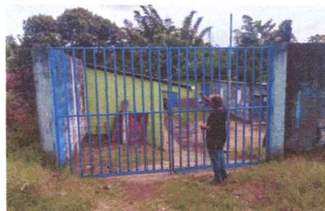
MANTENIMIENTO A PORTON
