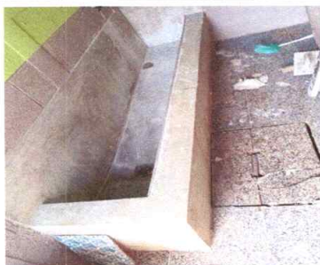
REPARACION DE URINARIO
