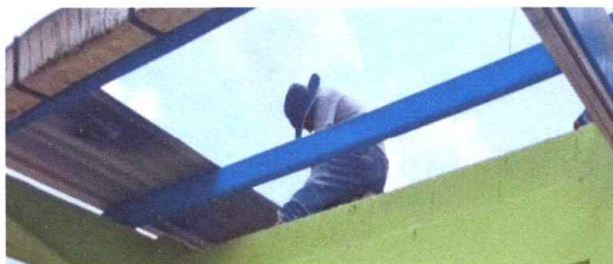
SUSTITUCION DE CUBIERTA METALICA
