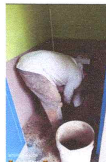
SUSTITUCION DE TAZA SANITARIA
