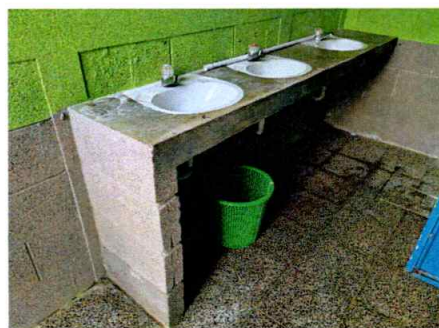
REPARACION DE MESA DE LAVAMANOS
