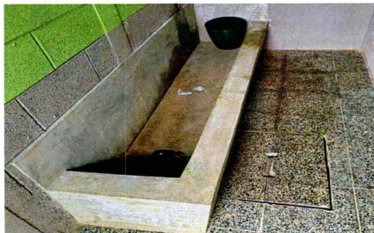
REPARACION DE URINARIO
