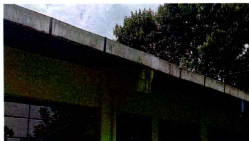
SUSTITUCION DE CANAL PLUVIAL
