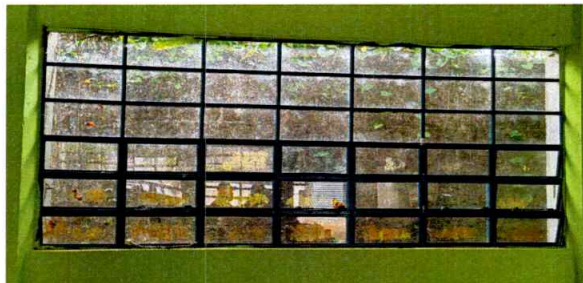
SUSTITUCION DE VENTANA
