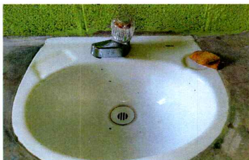
SUSTITUCION DE GRIFOS DE LAVAMANOS
