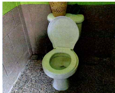
SUSTITUCION DE TAZA SANITARIA
