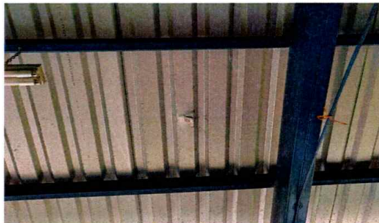
SUSTITUCION DE CUBIERTA METALICA
