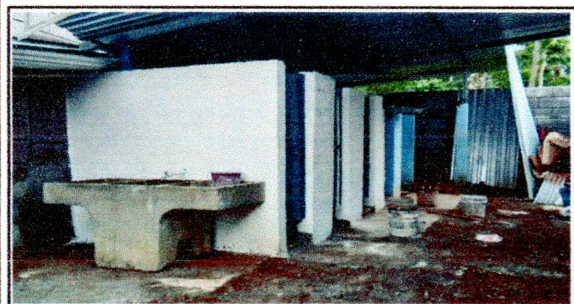
3. Mantenimiento de muro en baños. (15.00 m2).
