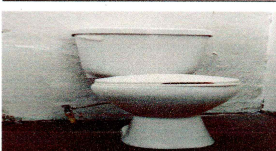
6. Mantenimiento de inodoro. (3.00 Unidades).
