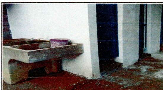
4. Sustitución de emplastado de muro, por emplastado de muro de block 0.15m X 0.20m X 0.40m. Y pastilla de concreto de 0.20m X 0.40m para mejora en estabilización de suelo. (9.60 m2).
