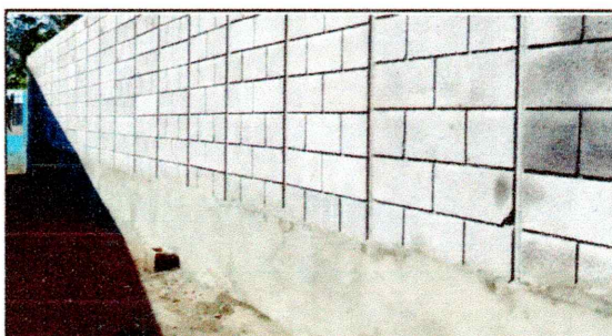
2. Sustitución de emplastado de muro, por emplastado de muro de block 0.15m X 0.20m X 0.40m. Y pastilla de concreto de 0.20m X 0.40m para mejora en estabilización de suelo. (46.40 m2).
