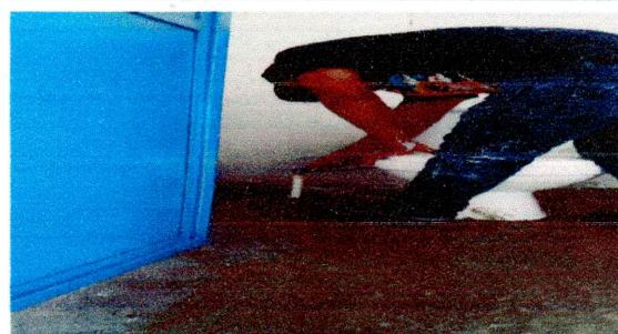
6. Mantenimiento de inodoro. (3.00 Unidades).
