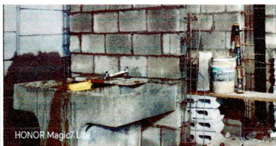
3. Mantenimiento de muro en baños. (15.00 m2).
