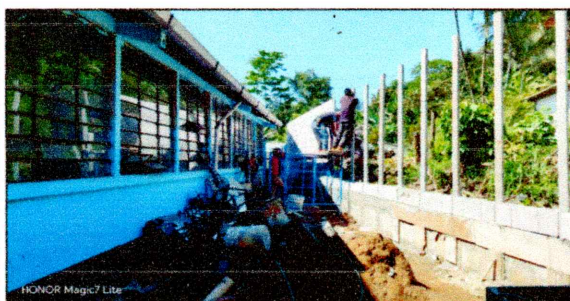
1. Sustitución de muro perimetral, por muro perimetral prefabricado de placa y poste de concreto. Altura 2.5m. (72.50 m2).
