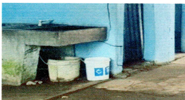
4. Sustitución de emplantillado de muro, por emplantillado de muro de block 0.15m X 0.20m X 0.40m. Y pastilla de concreto de 0.20m X 0.40m para mejora en estabilización de suelo. (9.60 m2).
