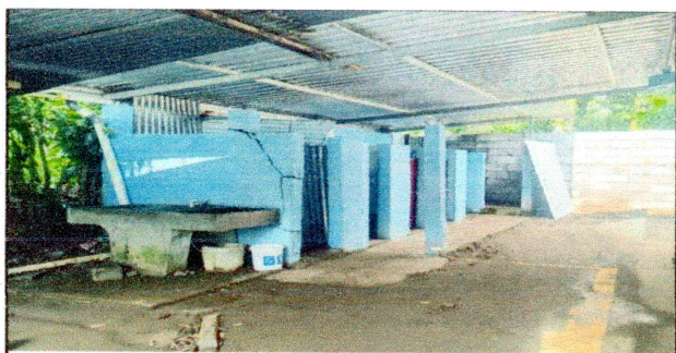
3. Mantenimiento de muro en baños. (15.00 m2).
