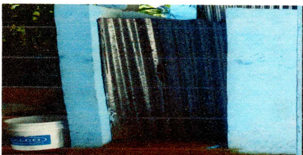
5. Sustitución de puerta, por puertas de metal para baño. (3.00 Unidades).
