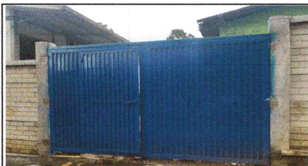
SUSTITUCION DE PORTON DE 3*2.10
