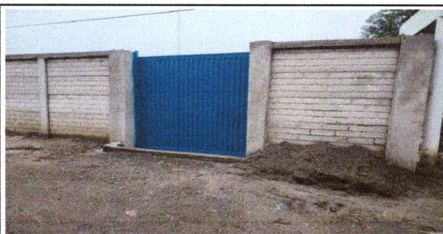
SUSTITUCION DE PORTON DE 2*2.10
