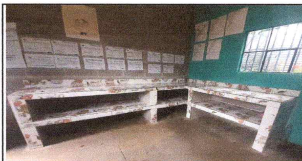
MESA DE CONCRETO
