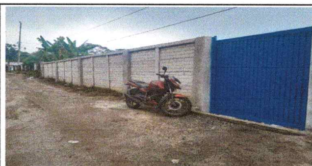
SUSTITUCION DE PORTONES
