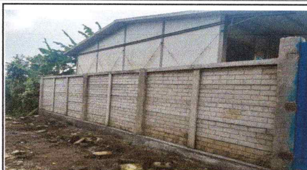
SUSTITUCION DE MURO PERIMETRAL PREFABRICADO
