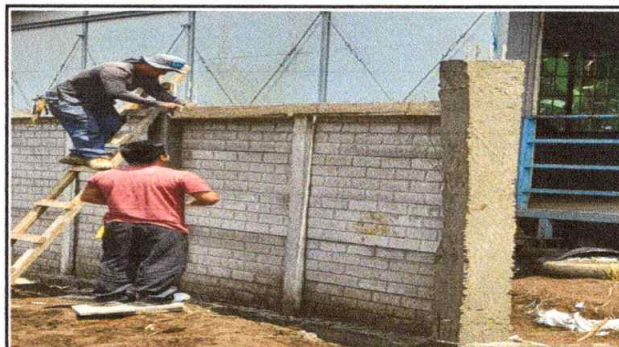
SUSTITUCION DE MURO PERIMETRAL PREFABRICADO
