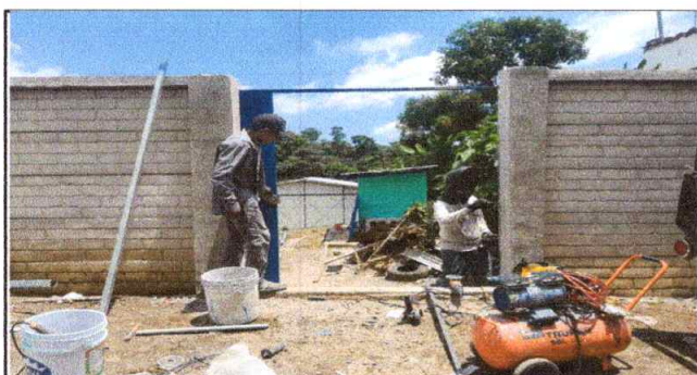
SUSTITUCION DE PORTON DE 2*2.10
