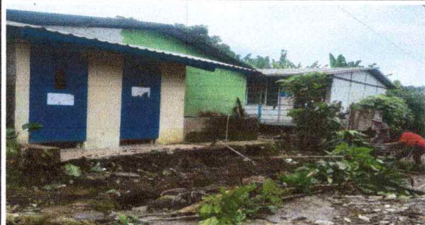
SUSTITUCION DE MURO PERIMETRAL PREFABRICADO
