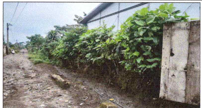
SUSTITUCION DE MURO PERIMETRAL PREFABRICADO
