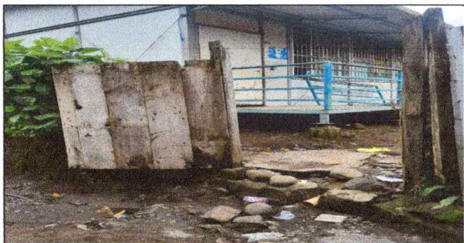
SUSTITUCION DE PORTON DE 3*2.10
