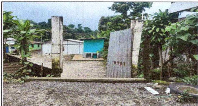
SUSTITUCION DE PORTON DE 2*2.10
