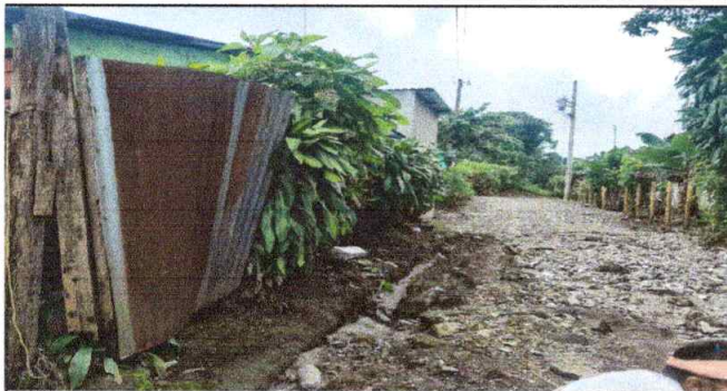
SUSTITUCION DE MURO PERIMETRAL PREFABRICADO
