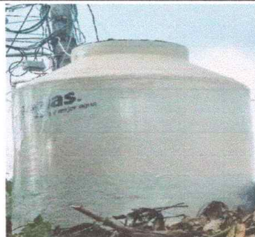
Foto 4: SUSTITUCIÓN DE CISTERNA ROPLAS, CAPACIDAD 1,100 Lts
