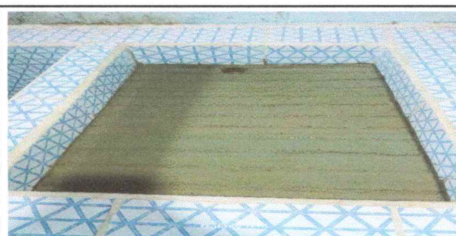
Foto 6: SUSTITUCIÓN DE AZULEJO EN PILA DE CONCRETO 10mts2
