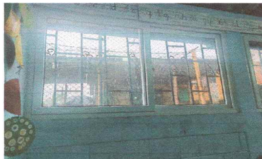
Foto 2: SUSTITUCIÓN DE VENTANAS DE METAL 24mts2
