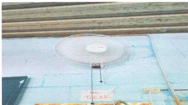
Foto 3: SUSTITUCIÓN DE VENTILADORES COLGANTES EN PARED
