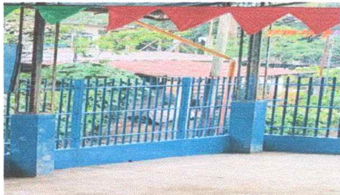
Foto1: SUSTITUCIÓN DE BALCONES METALICOS 84 mts2
