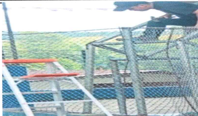
Foto1: Sustitución de balcones metálicos 84mts2
