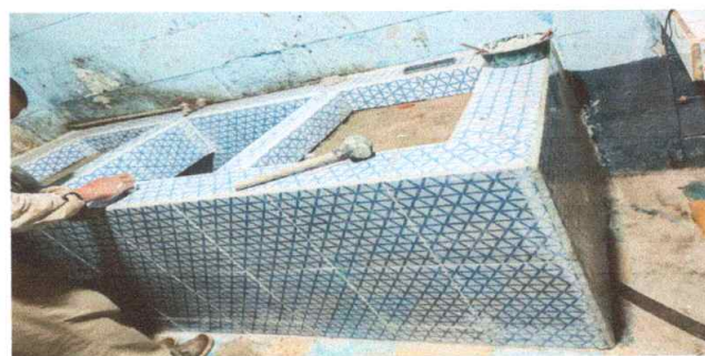
Foto 6: Sustitución de azulejo en pila de concreto 10 mts2
