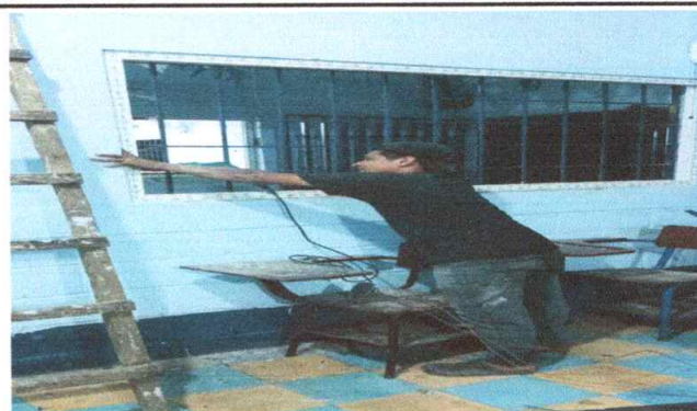
Foto 2: Sustitución de ventanas de metal 24 mts2
