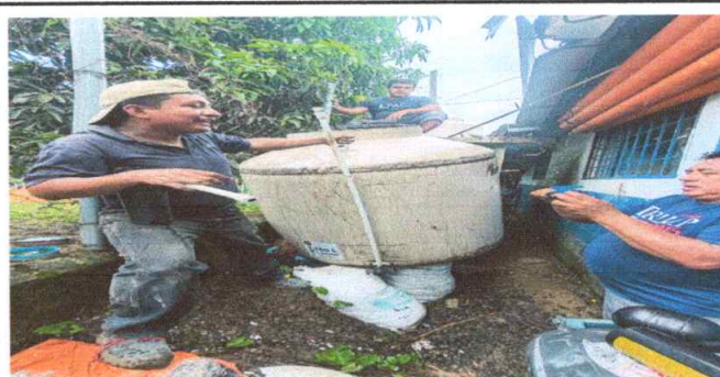
Foto 4: Sustitución de Cisterna Rotoplas, capacidad 1,100 Lts
