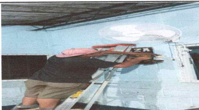
Foto 3: Sustitución de Ventiladores colgantes en pared
