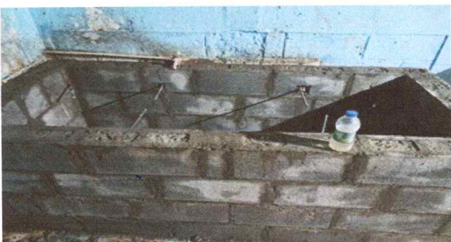
Foto 5: Sustitución de pila de concreto
