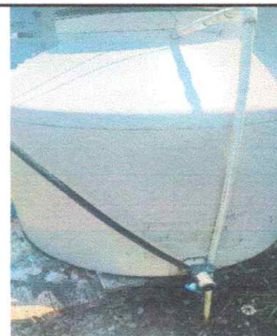
Foto 4: Sustitución de cisterna Rotoplas, capacidad 1,100 Lts
