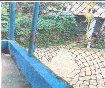
Foto 1: Sustitución de balcones metálicos 84mts2
