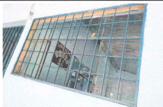
Foto 2: Sustitución de ventanas de metal 24mts2
